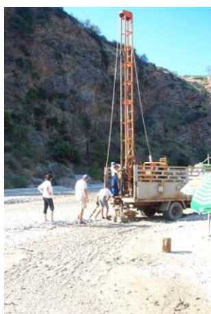
Σχήμα 4.10. Διάνοιξη γεωτρήσεων με τη χρήση γεωτρύπανου και τοποθέτηση πιεζομετρικών σωλήνων
