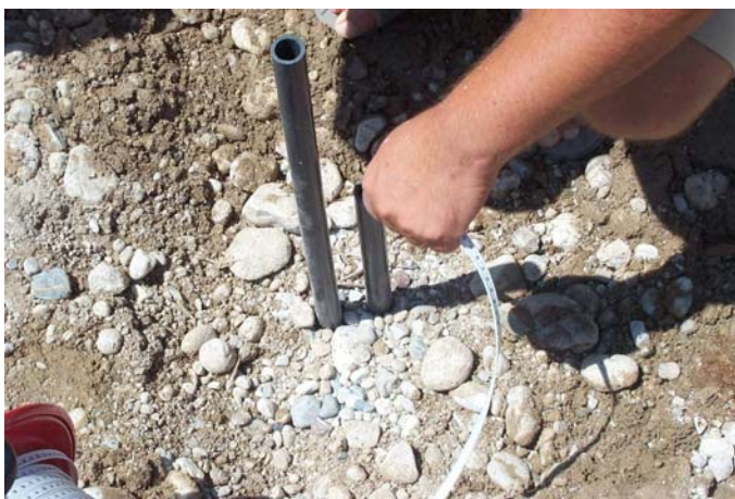
Σχήμα 4.10. Διάνοιξη γεωτρήσεων με τη χρήση γεωτρύπανου και τοποθέτηση πιεζομετρικών σωλήνων
