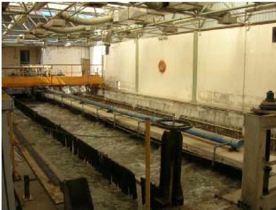
Σχήμα 45: Δεξαμενές εξάμμωσης και λιποσυλλογής (εσωτερικός χώρος).
