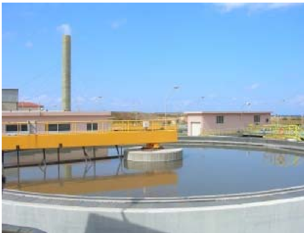
Σχήμα 46: Δεξαμενή πρωτοβάθμιας καθίζησης (εξωτερικός χώρος).
