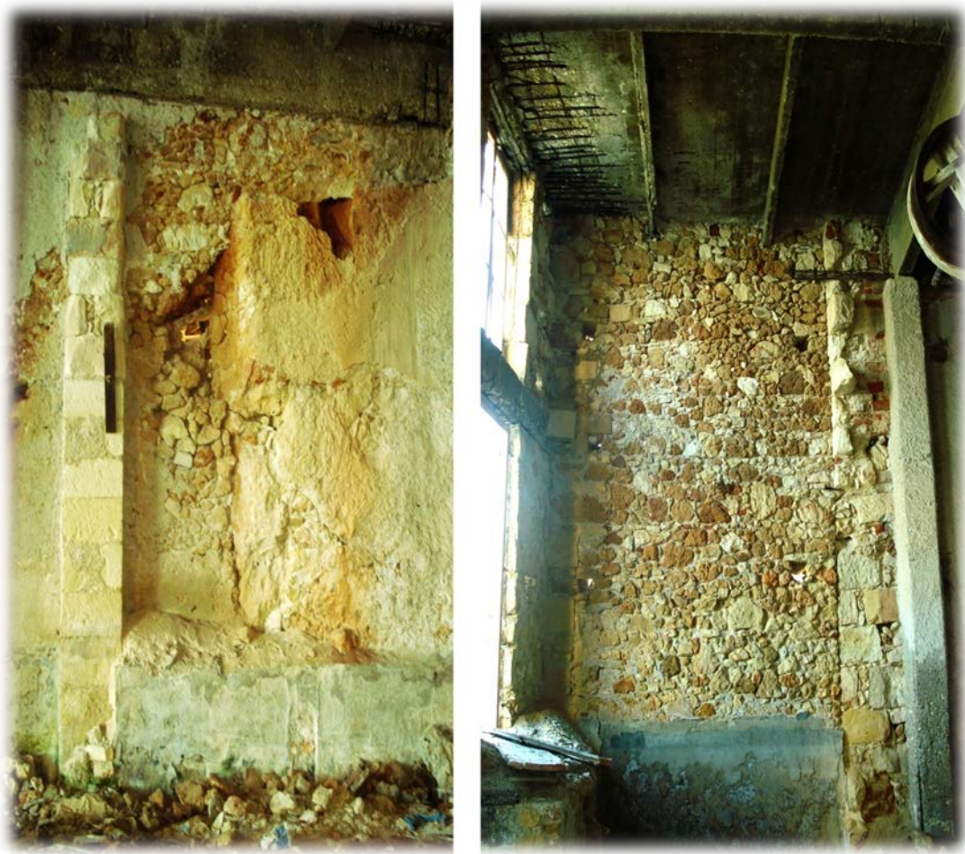
Εικ.19: Μερική πτώση των υλικών πλήρωσης της βορειοανατολικής μεσοτοιχίας του κτιρίου Δεξιά, εμφανής αρμός της νέας προσθήκης του κτιρίου
