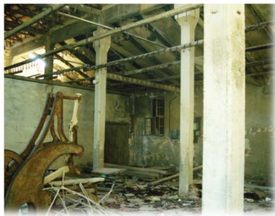
Εικ.21: Απεικόνιση φθορών στέγης οπλισμένου σκυροδέματος Παρατηρείται έντονη αποφλοίωση και διάβρωση του οπλισμού
