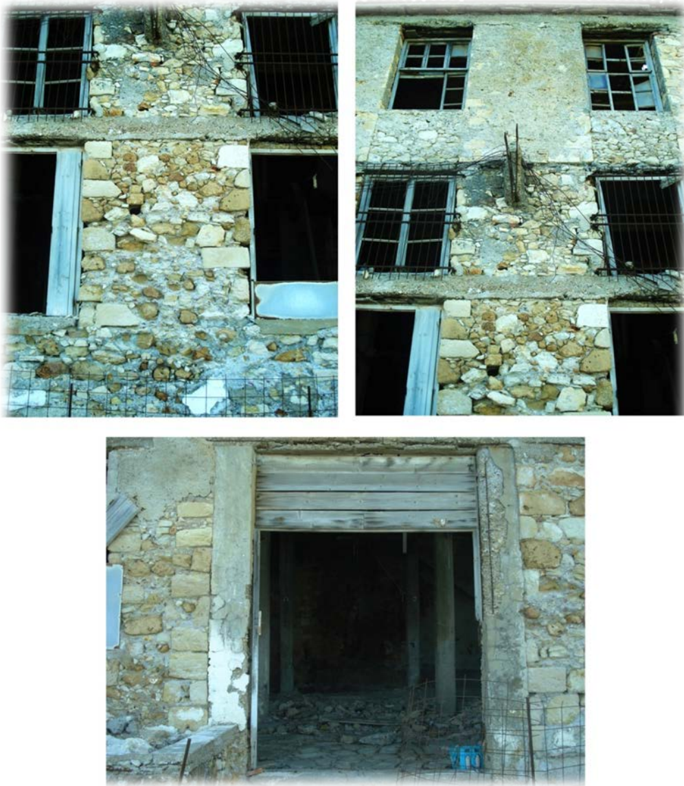
Εικ.16: Αριστερά, φθορές συνδετικού κονιάματος λόγω υγρασίας και διάβρωση οπλισμένου σκυροδέματος (σενάζ) με αποτέλεσμα την αποφλοιώση και εμφάνιση του οπλισμού του. Δεξιά, έντονη φθορά σκυροδέματος στα στοιχεία οπλισμένου σκυροδέματος και πλήρης απουσία του μπαλκονιού που υπήρχε στο κτίριο με εναπομένον στοιχείο αυτό της αντηρίδας στήριξης του. Κάτω, Έντονες τριχοειδής ρηγματώσεις και αποφλοιώσεις οπλισμένου σκυροδέματος
