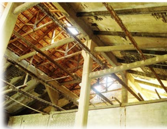
Εικ.21: Απεικόνιση φθορών στέγης οπλισμένου σκυροδέματος Παρατηρείται έντονη αποφλοίωση και διάβρωση του οπλισμού
