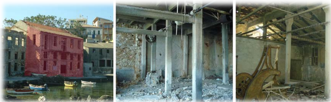
Εικ.14: Επεμβάσεις σε διαφορετικές χρονικές φάσεις: Προσθήκη νέου τμήματος (αριστερά), Υποστυλώματα από οπλισμένο σκυρόδεμα (κέντρο), στήριξη στέγης (δεξιά)
