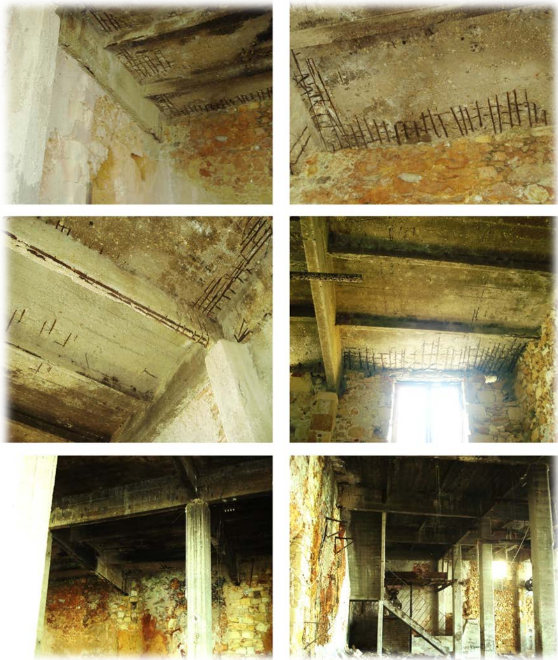
Εικ.20: Απεικόνιση φθορών στοιχείων οπλισμένου σκυροδέματος ισογείου επιπέδου
