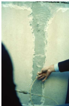
Εικόνα 1.6 Εισαγωγή ενέματος σε ρωγμή
