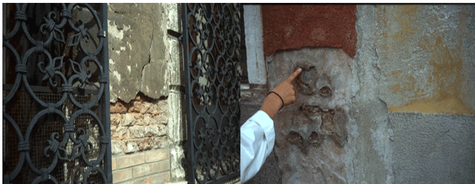
Εικόνα 3.12 Χαρακτηριστικά παραδείγματα καταστροφών από την επίδραση αλάτων σε επιφάνειες
