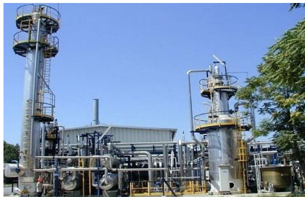
Εικόνα 2.2: Σύστημα Καταλυτικής υγρής οξείδωσης της εταιρείας ATOFINA στην Ιταλία, Crystallizer Mother Liquor
