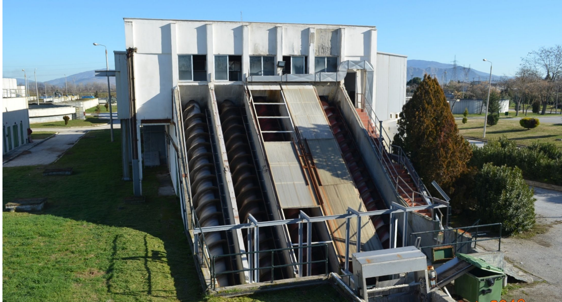
Εικόνα 4: Αντλιοστάσιο ανύψωσης
