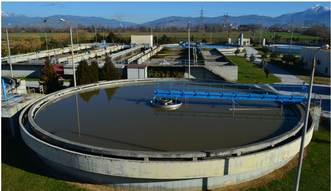
Εικόνα 6: Δεξαμενή πρωτοβάθμιας καθίζησης
