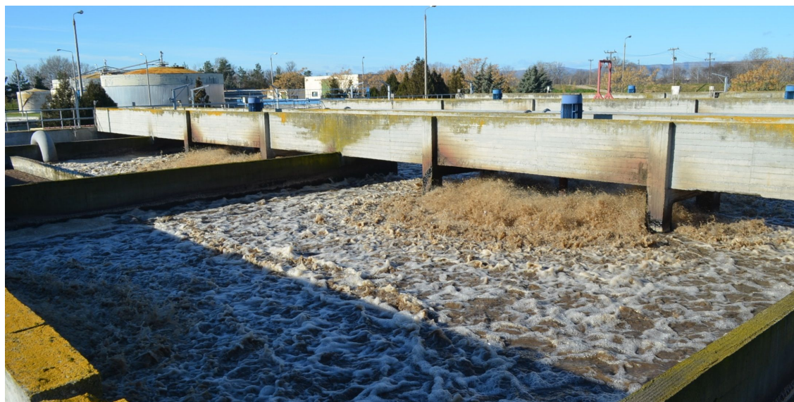
Εικόνα 7: Δεξαμενές επιφανειακού αερισμού λυμάτων
