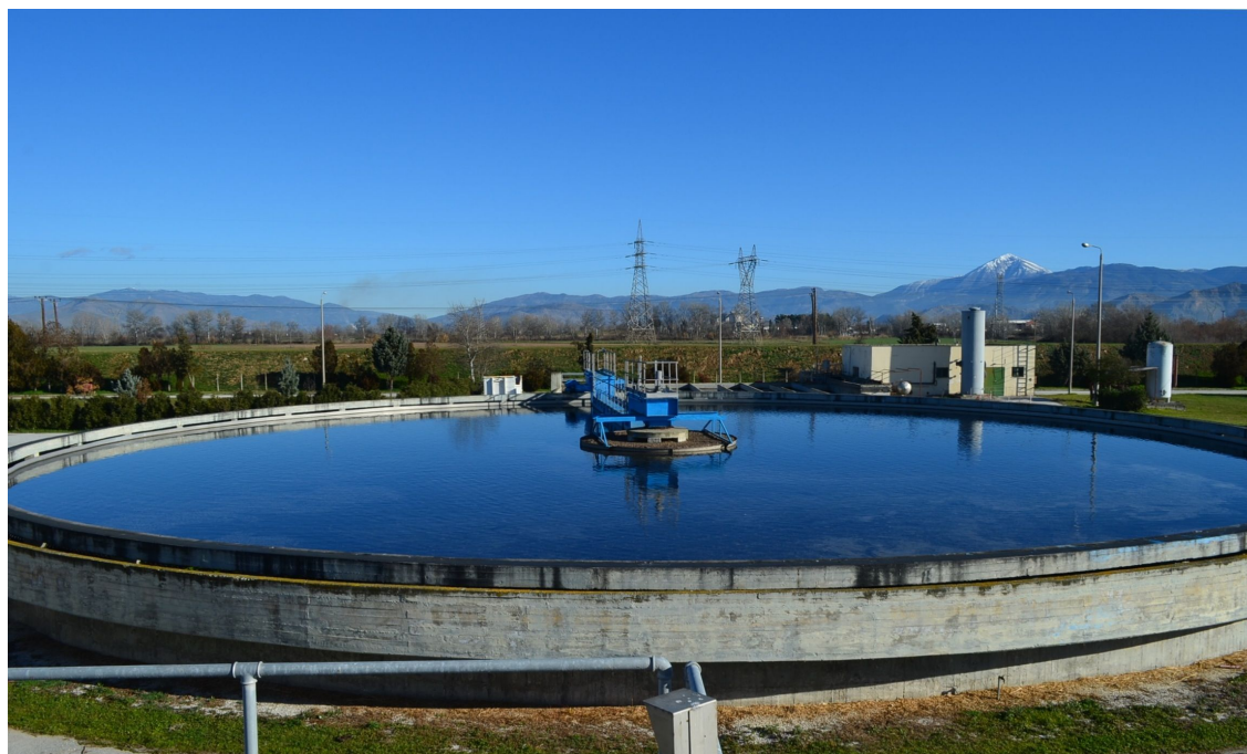
Εικόνα 9: Δεξαμενή δευτεροβάθμιας καθίζησης
