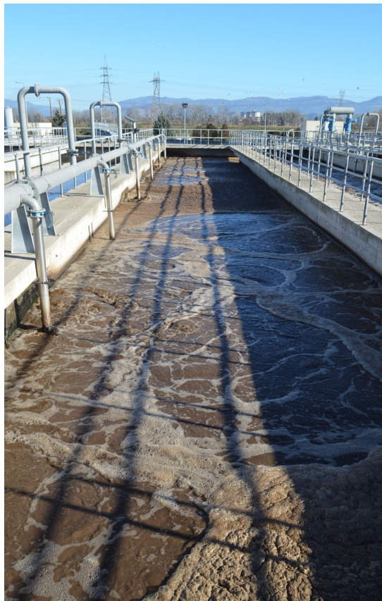
Εικόνα 8: Δεξαμενές αερισμού λυμάτων με υποβρύχια διάχυση
