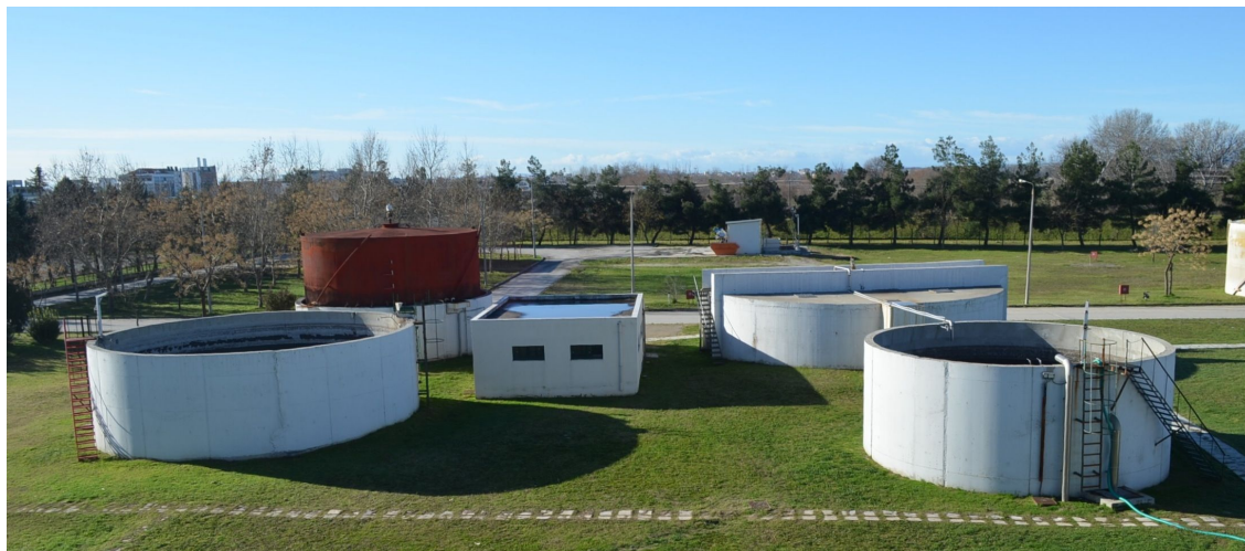
Εικόνα 11: Εγκαταστάσεις ομογενοποίησης, πάχυνσης, αποθήκευσης ιλύος και αεροφυλάκιο
