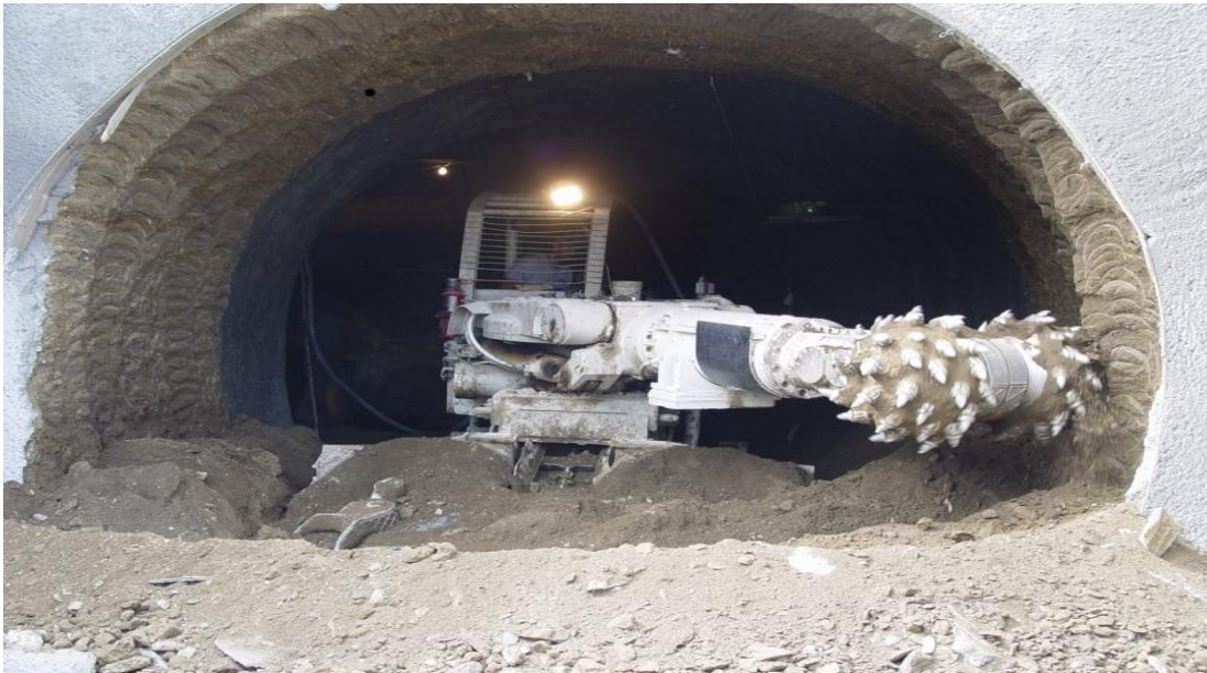
Σχήμα 4.4: Μηχανή όρυξης Road header (Εξαδάκτυλος, 2006)
