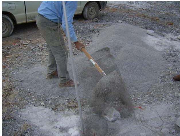
Σχήμα 1.3. Επιγόμωση των διατρημάτων με άμμο.
