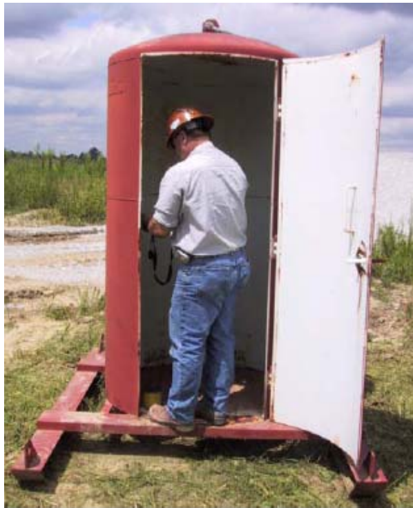
Σχήμα 2.13. Καταφύγιο πυροδότη για την αποφυγή τραυματισμών από ανεξέλεγκτη εκτόξευση πετρωμάτων.
