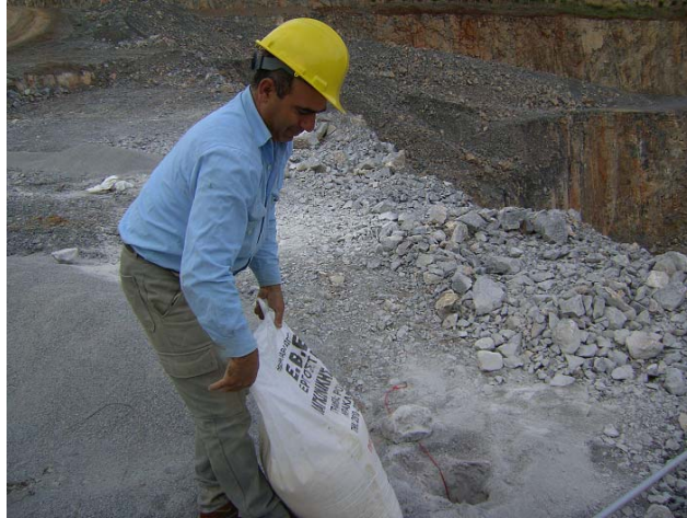
Σχήμα 2.5. Η χειρωνακτική μεταφορά βαρέων φορτίων εκρηκτικών επιβαρύνει τους εργαζόμενους.
