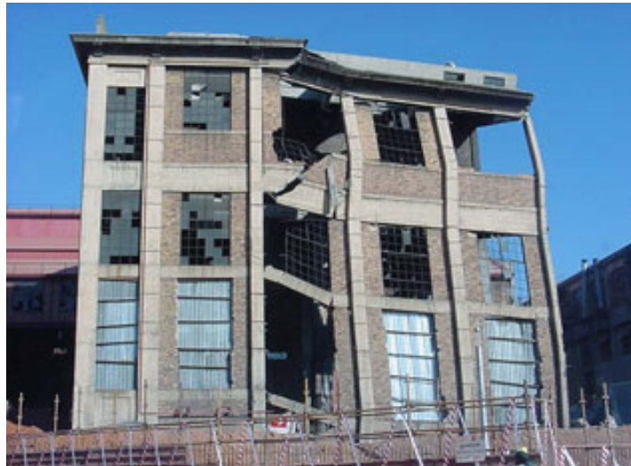
Σχήμα 2.11. Σημαντικές βλάβες στον φέροντα οργανισμό της κατασκευής.
