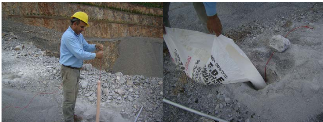
Σχήμα 1.2. Γόμωση διατρημάτων με φυσίγγια και ANFO.
