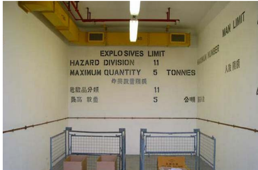
Σχήμα 2.4. Εσωτερικός χώρος αποθήκης εκρηκτικών υλών. Φαίνεται το ξύλινο πάτωμα, ο εξαερισμός και ο φωτισμός της αποθήκης.
