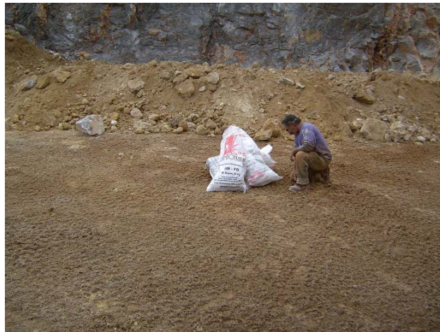
Σχήμα 2.16. Καταστροφή εκρηκτικών υλών με καύση στο λατομείο Γουρνών.
