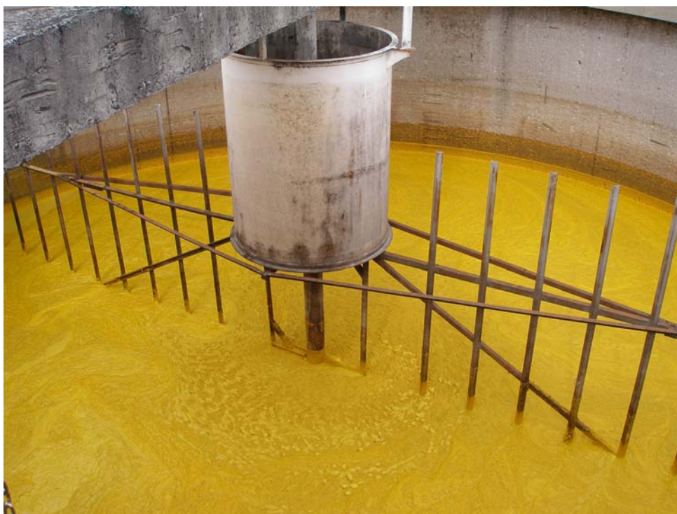
3-2 Δεξαμενή εξισορρόπησης ροής και φορτίων
