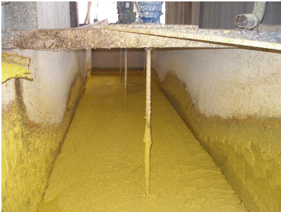
4-4 Δεξαμενή υποδοχής ξαφρισμάτων μετά τις διεργασίες επίπλευσης με διαλυμένο αέρα
