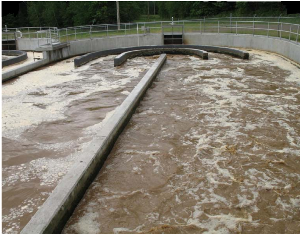
3-6 Αεριζόμενη λιμνοδεξαμενή αιωρούμενης βιομάζας
