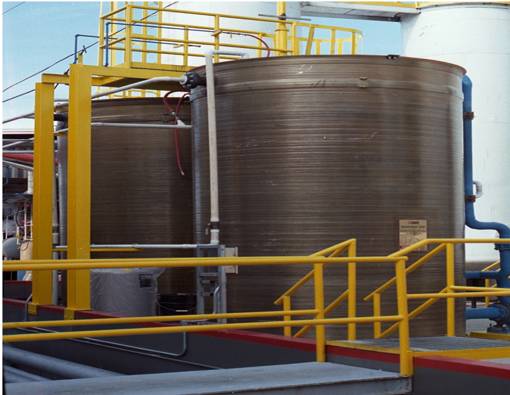
3-5 Αντιδραστήρες εναλλασσόμενων φάσεων διαλείποντος έργου
