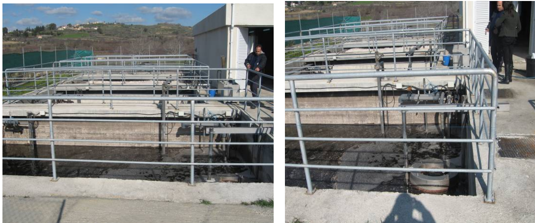
Εικόνα 2: Α΄ και Β΄ στάδιο βιολογικής επεξεργασίας
