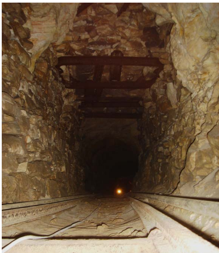
Εικόνα 4.27. Τοίχος αντιστήριξης εκατέρωθεν της στοάς
