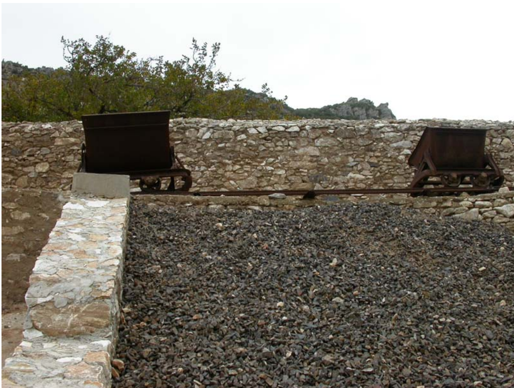
Εικόνα 2.22: Στραβολαγκάδα. Δύο βαγονέτα στην επίγεια σιδηροδρομική γραμμή πάνω από τις θυρίδες αποθήκευσης της ταξινομημένης σμύριδας.
