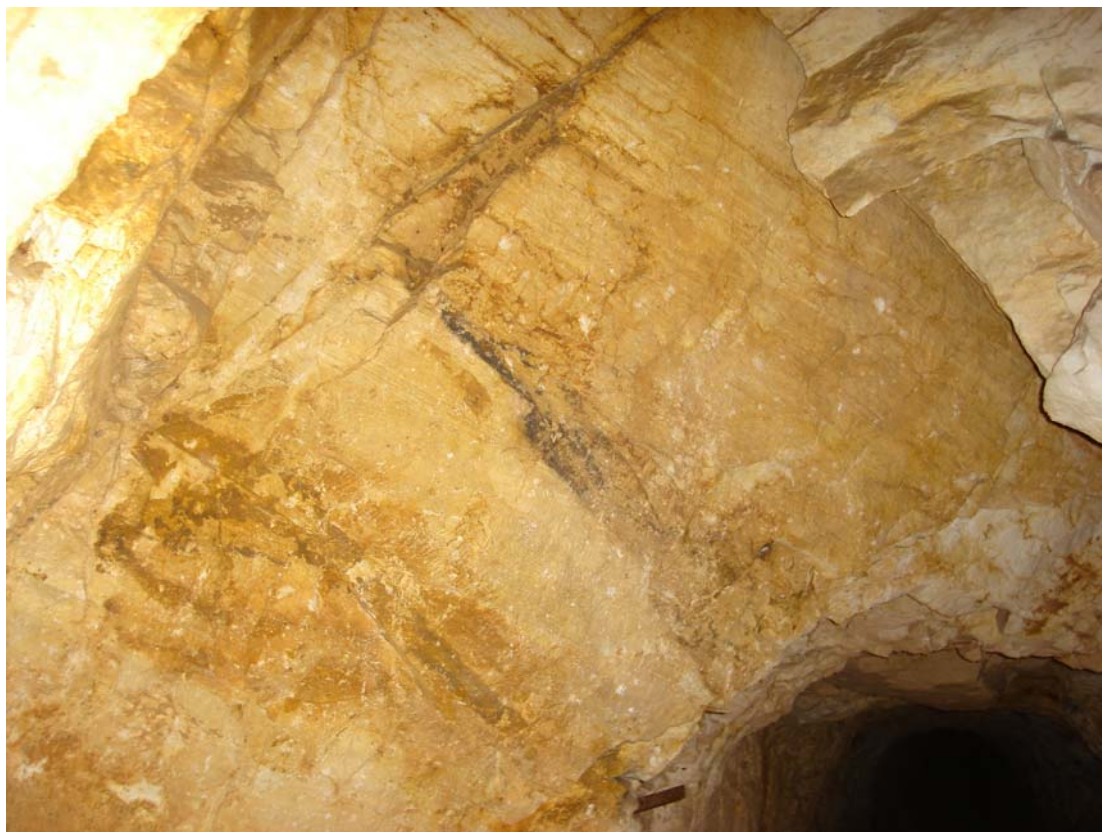
Εικόνα 4.18. Άποψη της σφήνας που υπήρχε στην οροφή της στοάς
