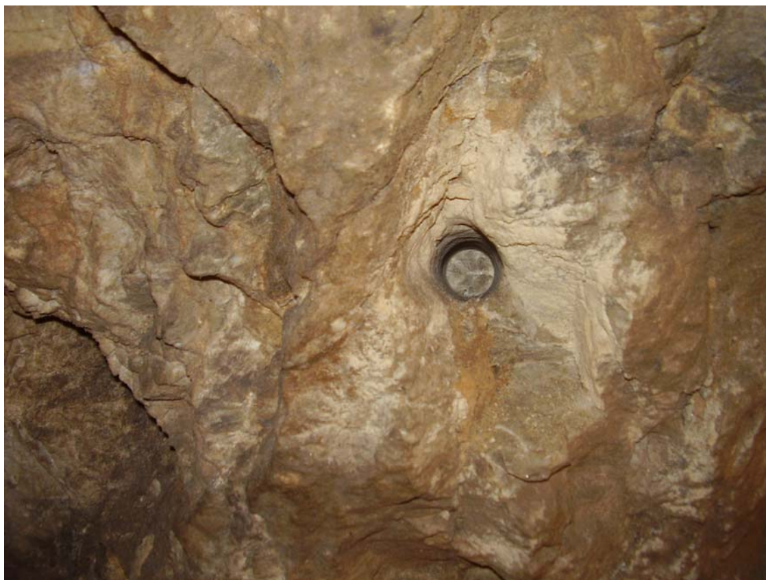
Εικόνα 2.8. Διάτρημα στο παραμέντο της στοάς που βρέθηκε στο ορυχείο.
