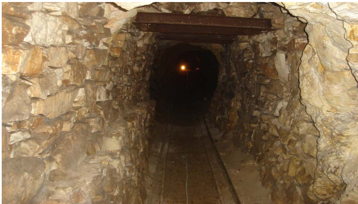
Εικόνα 4.27. Τοίχος αντιστήριξης εκατέρωθεν της στοάς
