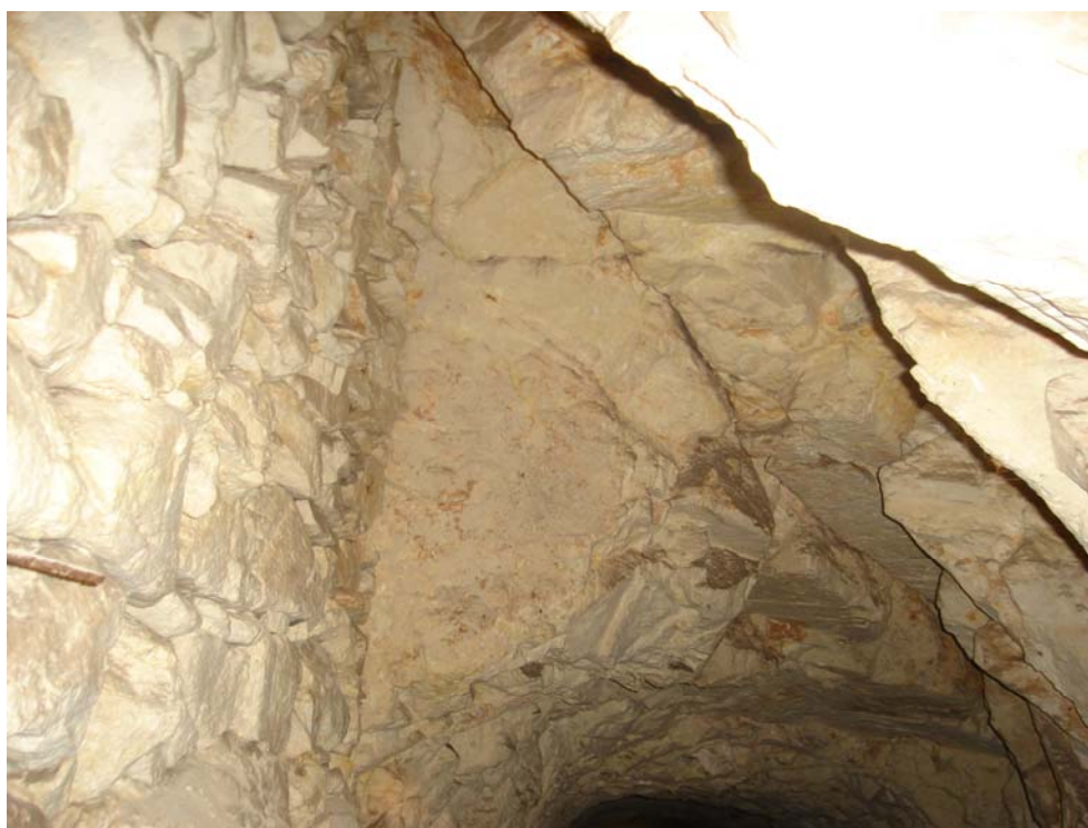
Εικόνα 4.26. Άποψη της σφήνας που βρίσκεται πάνω από τον τοίχο αντιστήριξης
