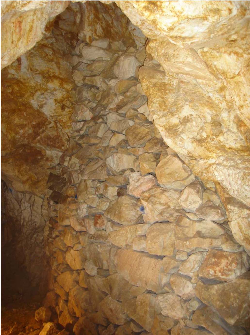
Εικόνα 4.21. Λιθόκτιστος τοίχος αντιστήριξης. Στην οροφή διακρίνεται ύπαρξη παλαιότερης σφήνας.
