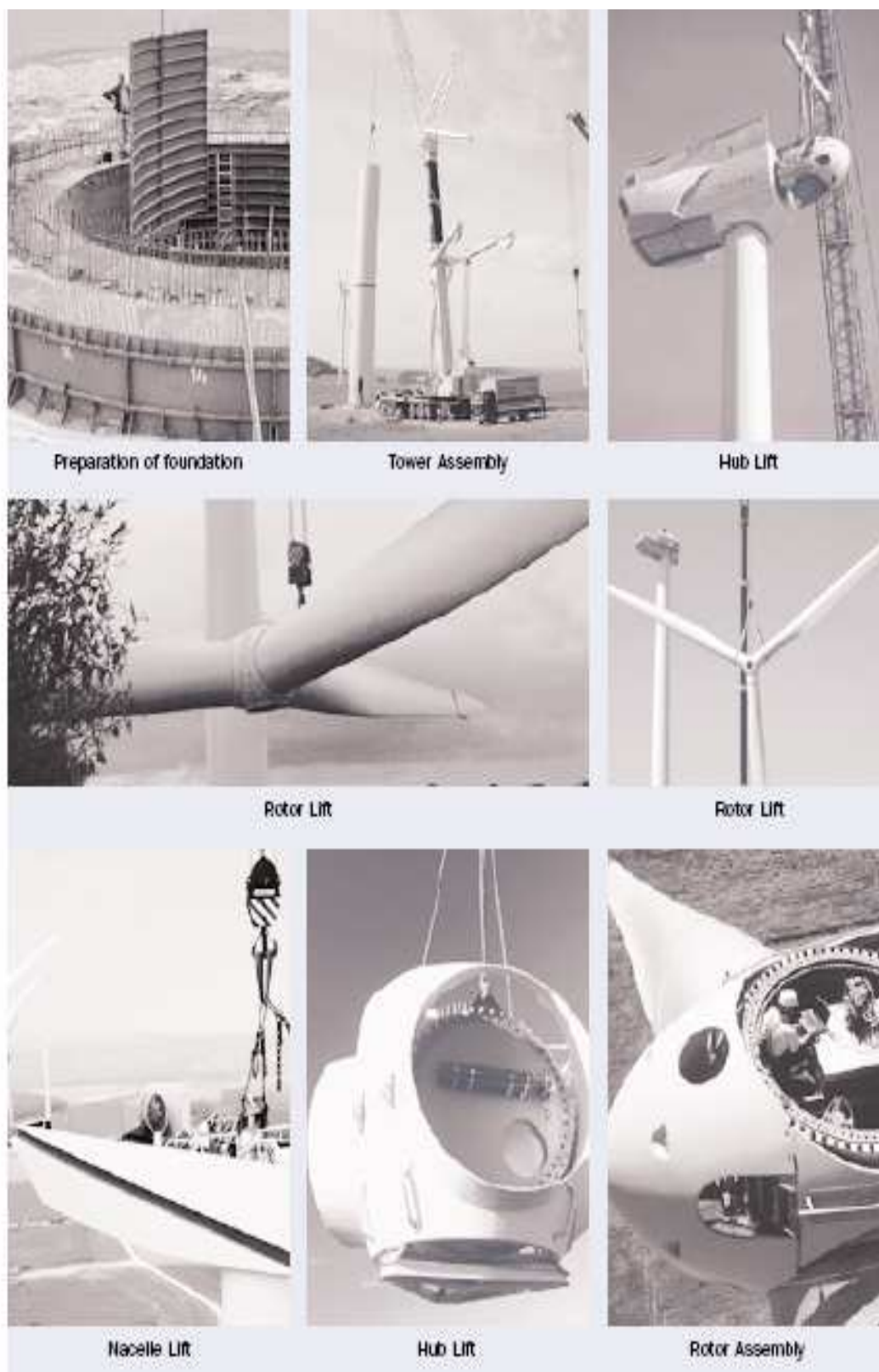
Σχήμα 2.18: Διαδικασία ανέγερσης μεγάλων ανεμογεννητριών
