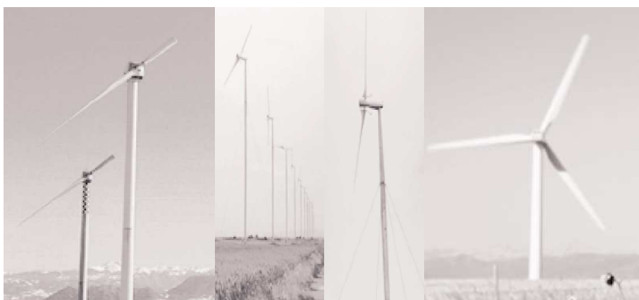
Σχήμα 2.10: Ανεμογεννήτριες οριζόντιου άξονα με ένα, δύο, και τρία πτερύγια
