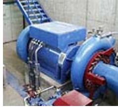
Εικόνα 7.2: Μικρή υδροηλεκτρική μονάδα 2MW στον ποταμό Osanica
