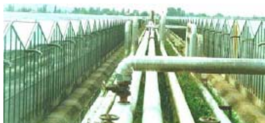
Εικόνα 9.2: Χρήση της γεωθερμίας στα Σκόπια για την θέρμανση θερμοκηπίων
