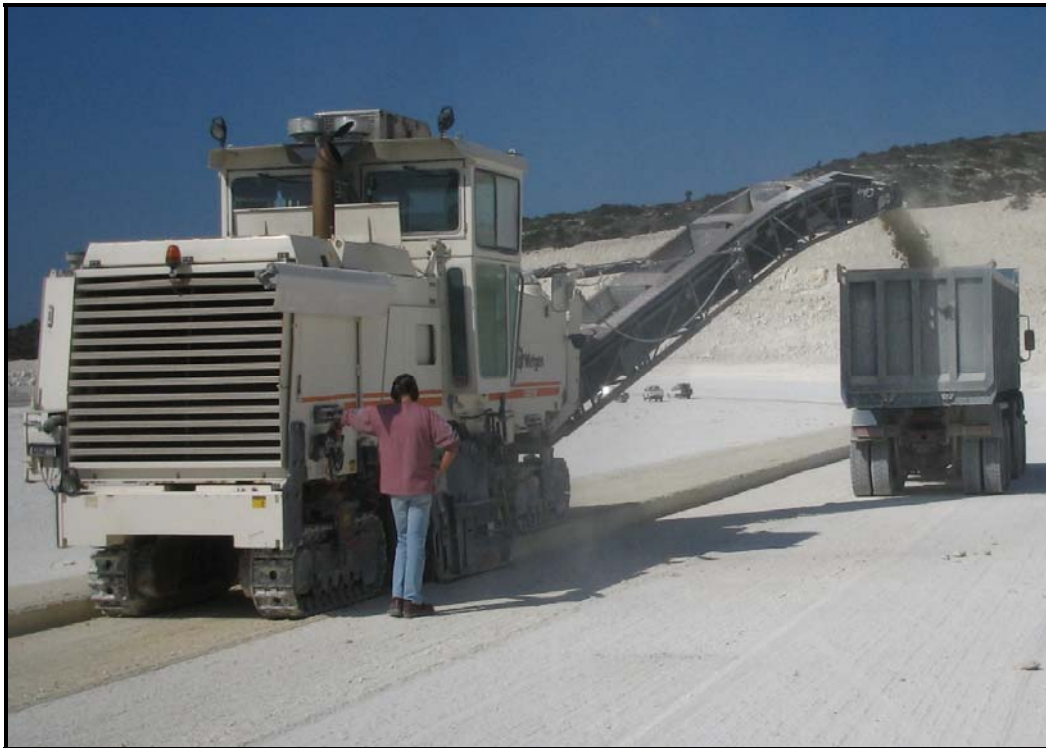
Σχήμα 7.4 Το μεταφορικό μέσον του υλικού στην εξορυγμένη επιφάνεια
