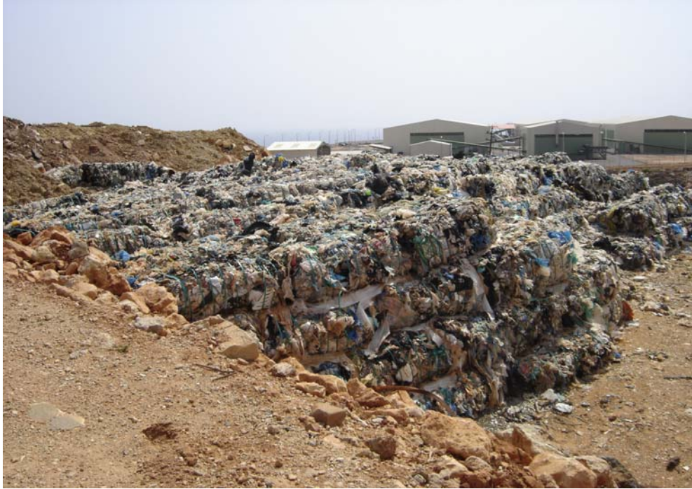
Εικόνα 21: Μια στρώση ολόκληρη από ακάλυπτα δεματοποιημένα απορρίμματα. Η περιτύλιξη κατεστραμμένη ολοσχερώς
