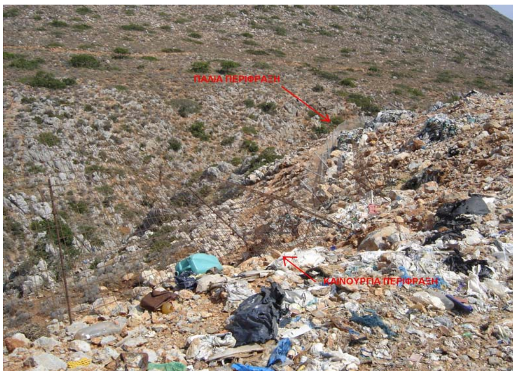
Εικόνα 15: Νέα και παλιά περίφραξη. Και οι δυο έχουν υποστεί ζημιές
