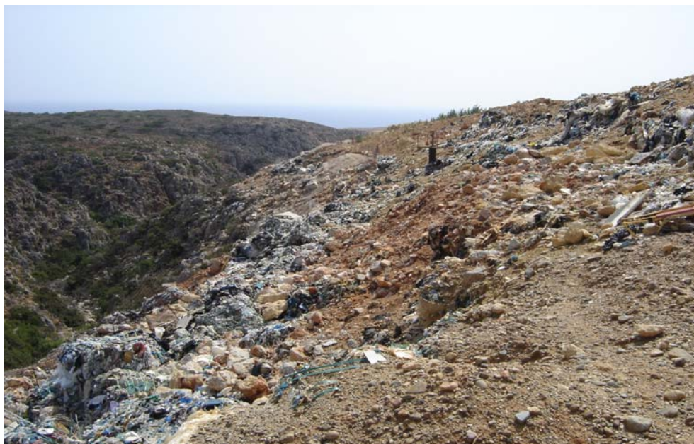
Εικόνα 17: Μια γενική άποψη της επικρατούσας κατάστασης. Η περίφραξη επικαλυμμένη από δεματοποιημένα απορρίμματα και υλικό επικάλυψης. Τα απορρίμματα με την βοήθεια της επιφανειακής απορροής ή του αέρα μπορούν να ‘κυλήσουν’ ελεύθερα στην χαράδρα που περιβάλλει το ‘Μεσομούρι’
