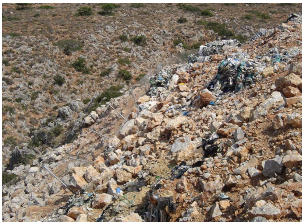
Εικόνα 16: Η παλιά περίφραξη υπέστη ζημιές από την προσπάθεια επικάλυψης των δεματοποιημένων απορριμμάτων
