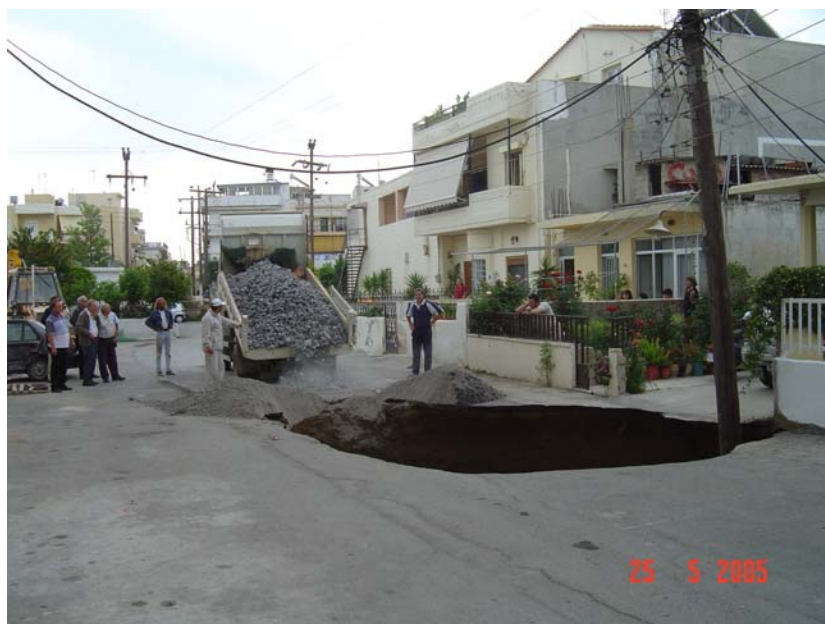
Εικόνα 3.8: Εμφάνιση επιφανειακού κρατήρα λόγω κατάρρευσης του μετώπου μίας σήραγγας κατά την φάση εκσκαφής.
