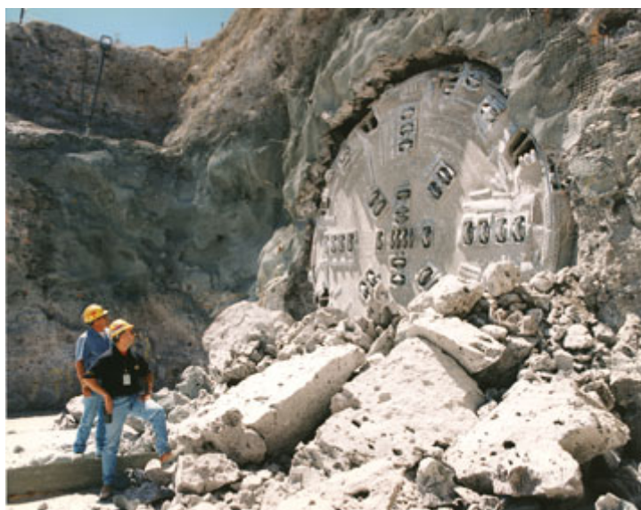
Εικόνα 2.3: TBM κατά την έξοδο του από την διάνοιξη σήραγγας σε βραχομάζα
