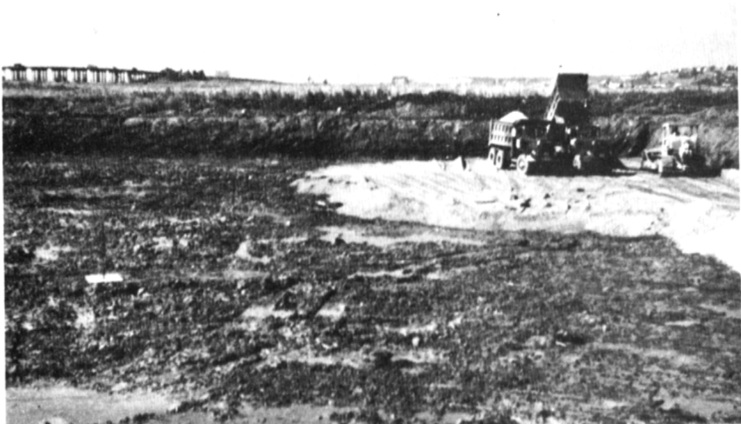
Σχήμα 5.3: Απομάκρυνση οργανικού εδάφους και εμφάνιση του αργιλικού εδάφους (Hunt, 1986)
