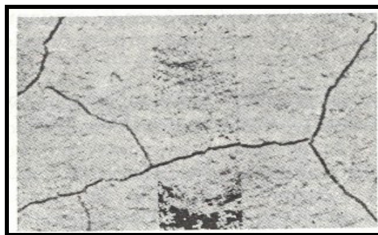
Εικόνα 3.1. Ρωγμές σε παχύ κονίαμα επιχρίσματος
