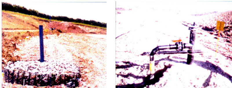
Φωτογραφίες πηγαδιών άντλησης και κεφαλών.
