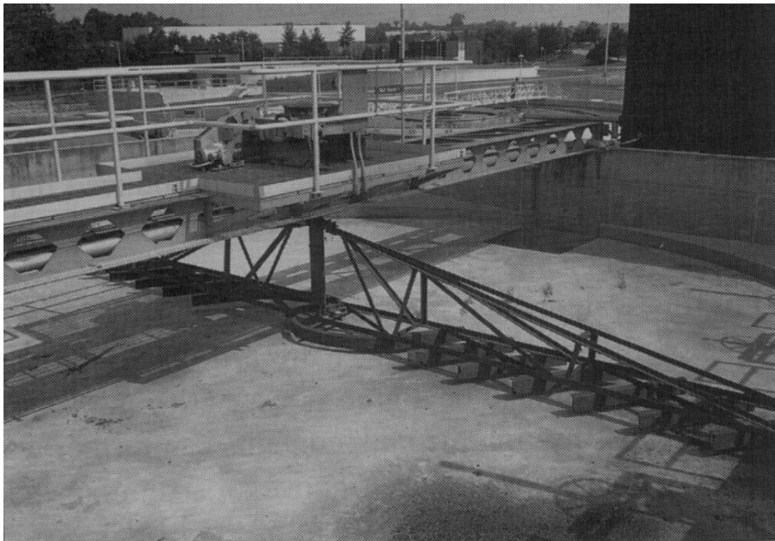
Σχήμα 4-3: Τυπικός αεριζόμενος εξαμμωτής (α) τομή, (β) φωτογραφία άδειας δεξαμενής εξοπλισμένης με γέφυρα για την απομάκρυνση της άμμου που έχει καθιζήσει [1].
