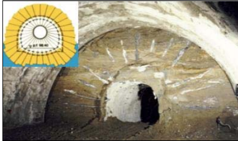
Σχήμα 2.9: Τσιμεντενέσεις στο μέτωπο (Peila et al , 2006)
