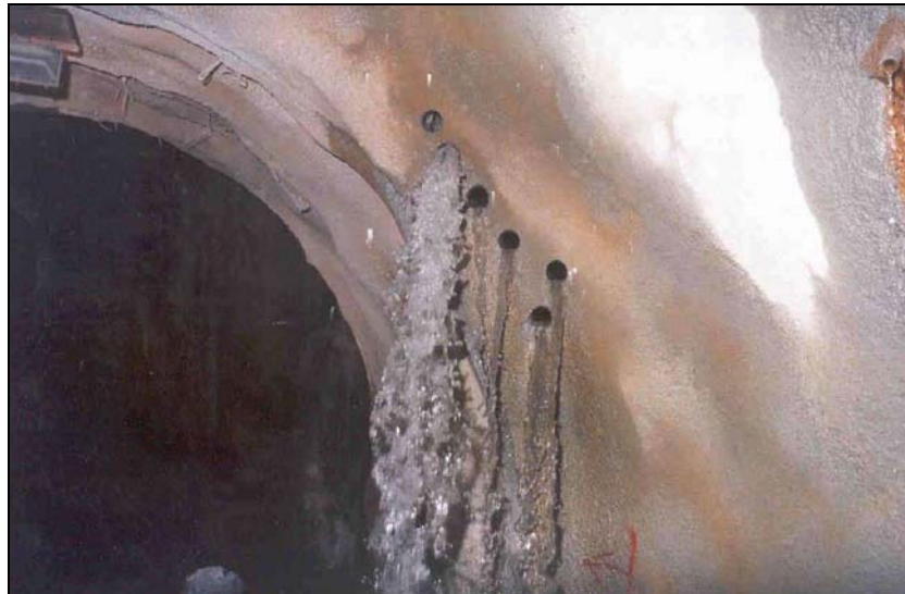
Σχήμα 2.13: Αποστράγγιση σήραγγας (Peila et al , 2006)
