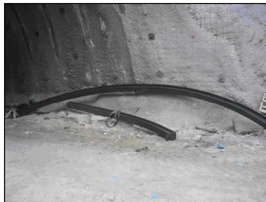
Σχήμα 2.16: Χαλύβδινό πλαίσιο HEB 180
