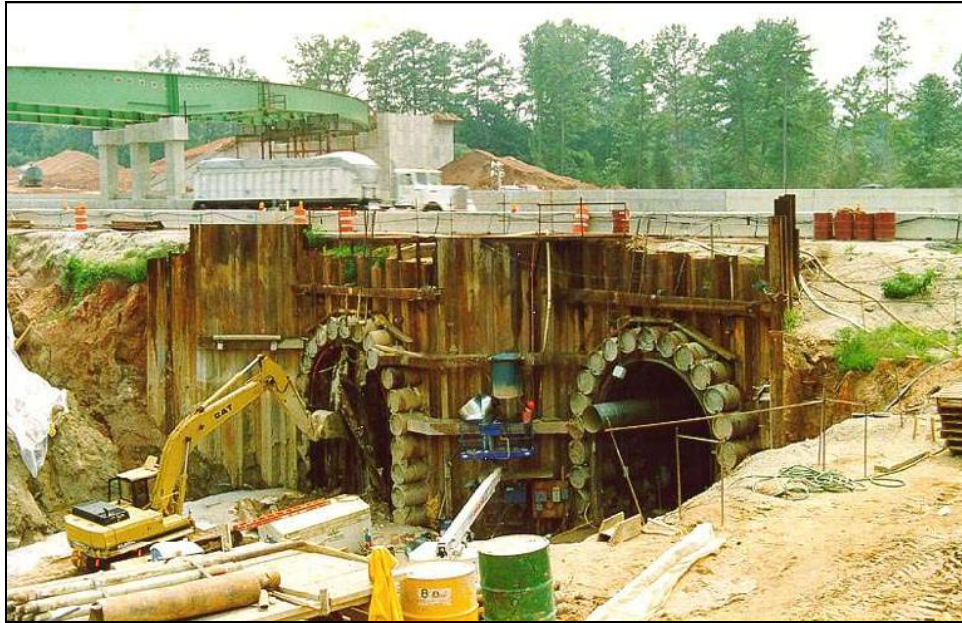
Σχήμα 3.5: Μέθοδος pipe roof κάτω από αυτοκινητόδρομο (Peila et al , 2006)
