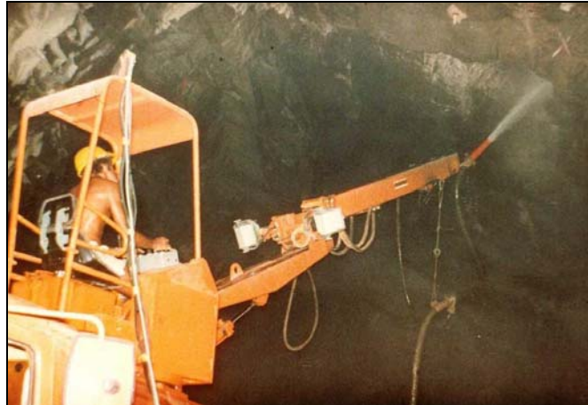
Σχήμα 2.15: Χρήση εκτοξευόμενου σκυροδέματος
