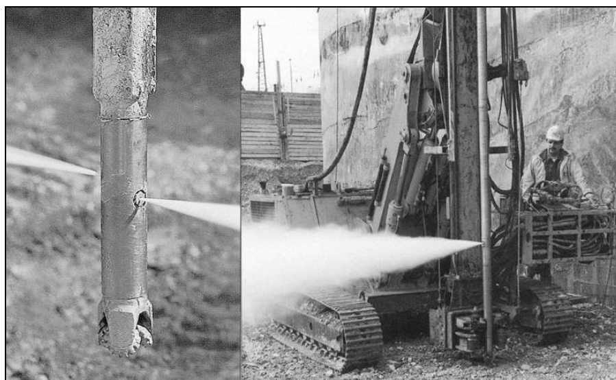
Σχήμα 2.11: Ψεκασμός μίγματος από τα ακροφύσια της διατρητικής στήλης (Καββαδάς, 2000)
