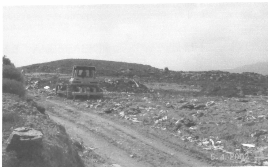
Εικόνα 13: Επιχωμάτωση στον ΧΥΤΑ Ρεθύμνου
