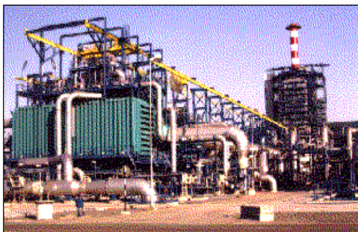
Σχήμα 3.4.2 MSF εργοστάσιο αφαλάτωσης θαλασσινού νερού δυναμικότητας 14400 m 3 /ώρα
