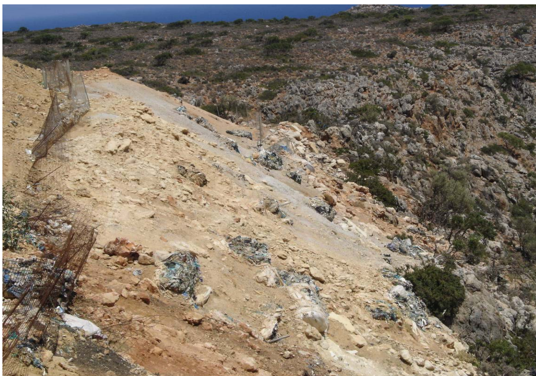
Εικόνα 23: Δεματοποιημένα απορρίμματα με κατεστραμμένο το υλικό περιτύλιξης ή απορρίμματα αποκολλημένα από τα δέματα ‘κυλούν’ στην χαράδρα του Μεσομουρίου.
