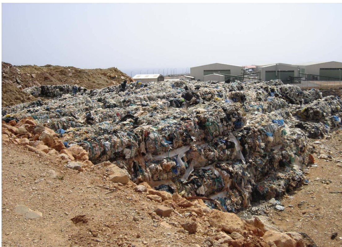
Εικόνα 21: Μια στρώση ολόκληρη από ακάλυπτα δεματοποιημένα απορρίμματα. Η περιτύλιξη κατεστραμμένη ολοσχερώς.
