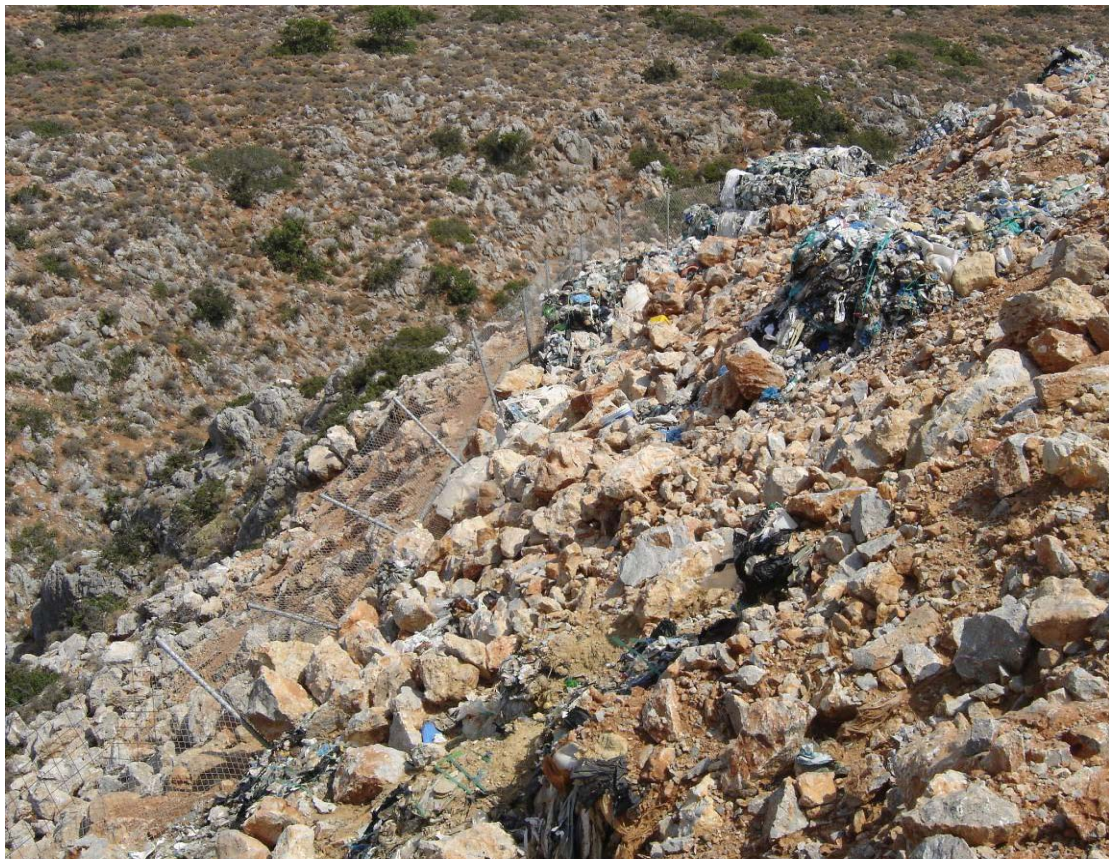
Εικόνα 16: Η παλιά περίφραξη υπέστη ζημιές από την προσπάθεια επικάλυψης των δεματοποιημένων απορριμμάτων.
