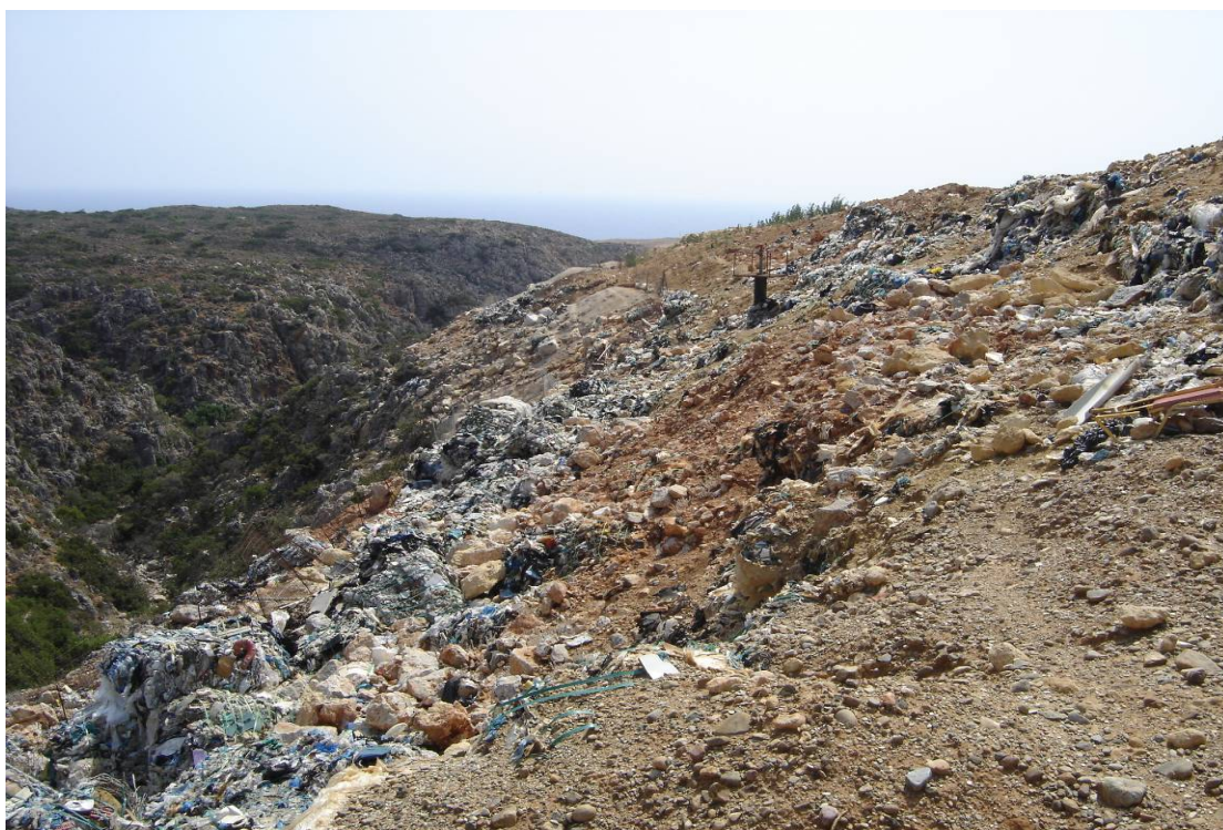
Εικόνα 17: Μια γενική άποψη της επικρατούσας κατάστασης. Η περίφραξη επικαλυμμένη από δεματοποιημένα απορρίμματα και υλικό επικάλυψης. Τα απορρίμματα με την βοήθεια της επιφανειακής απορροής ή του αέρα μπορούν να ‘κυλήσουν’ ελεύθερα στην χαράδρα που περιβάλλει το ‘Μεσομούρι’.
