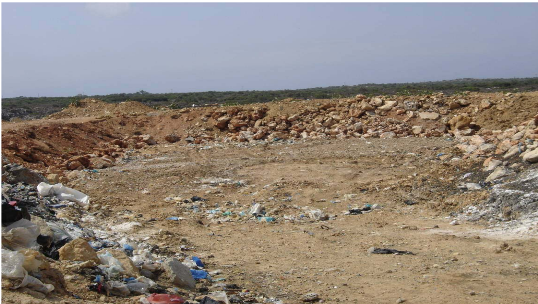
Εικόνα 25: Πάνω στο υλικό επικάλυψης δημιουργήθηκαν μεγάλες τρύπες κωνικού περιπίου σχήματος που χρησιμοποιήθηκαν σαν δεξαμενές λυματολάσπης
