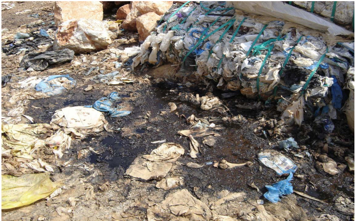
Εικόνα 32: Εξαιτίας της καταστροφής του περιτυλίγματος των δεματοποιημένων απορριμμάτων αλλά και της μη επικάλυψής τους, τα απορρίμματα έμειναν εκτεθειμένα στα κατακρημνίσματα με αποτέλεσμα την αύξηση της σχετικής υγρασίας των απορριμμάτων και την δημιουργία στραγγισμάτων.
