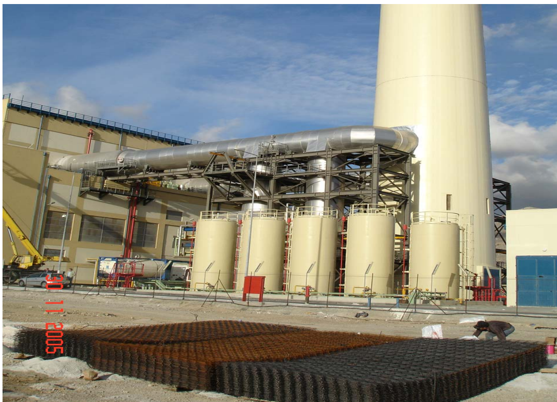
Εικόνα 29 - Μέτρα προστασίας για την αποφυγή εκτινάξεων. Δομικό πλέγμα πάνω από γεωύφασμα
