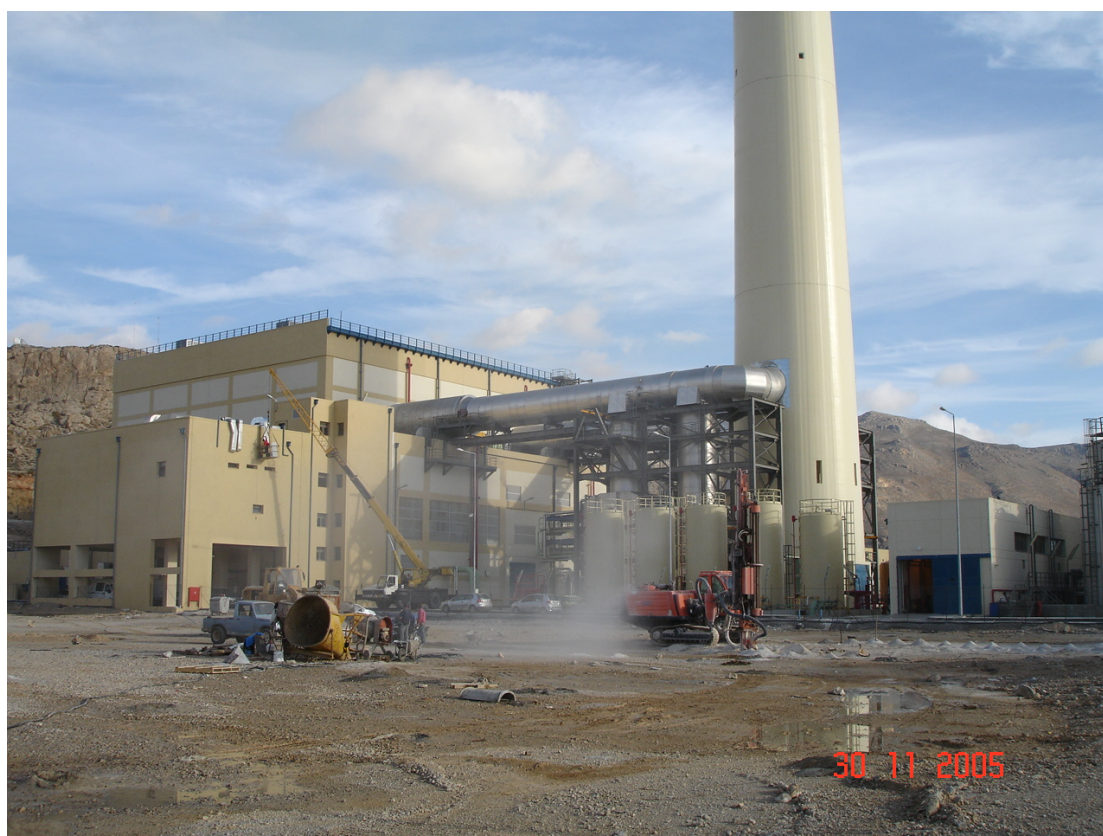
Εικόνα 15 - Διατρητικό μηχάνημα κατά την διάτρηση για την 1 η ανατίναξη
