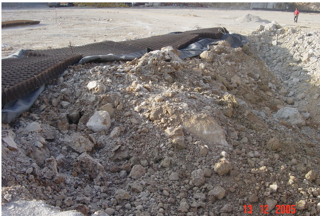
Εικόνα 28 - Δημιουργία προστατευτικού αναχώματος ως μέτρο προστασίας εκτινάξεων
