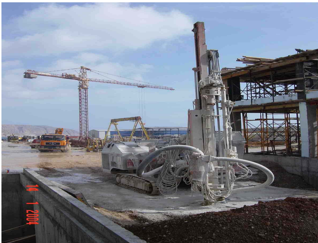
Εικόνα 8 – Κατά την προετοιμασία της ανατίναξης – διάτρηση
