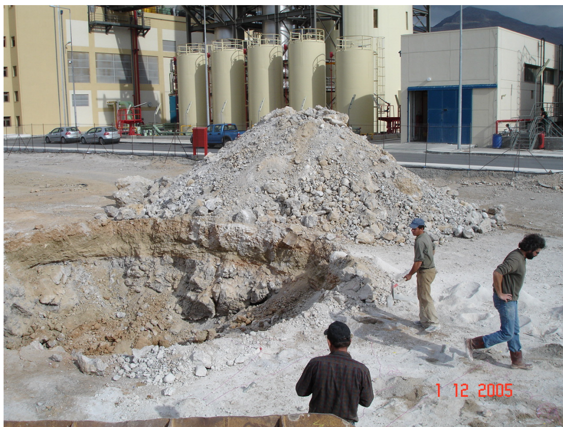
Εικόνα 27 - Δημιουργία προστατευτικού αναχώματος ως μέτρο προστασίας εκτινάξεων
