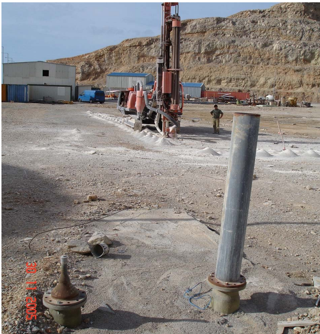
Εικόνα 32 - Δημιουργία ζώνης ανάσχεσης (προρηγμάτωσης) των σεισμικών κυμάτων από τις κοντινότερες κατασκευές (όπως διακρίνεται σε πρώτο πλάνο ο αγωγός νερού)
