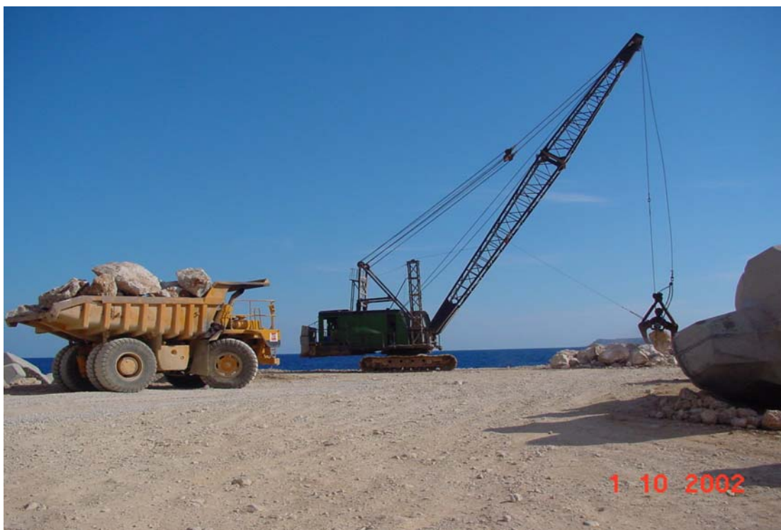
Εικόνα 3 - Εργασίες μεταφοράς ογκολίθων για την ενίσχυση του κυματοθραύστη, των νότιων πρανών και της ακτογραμμής Κατά την περίοδο των αναγνωριστικών μετρήσεων της 1 ης Φάσης του προγράμματος (01/10/2002 - 07/10/2002), πραγματοποιήθηκαν και ελέγχθηκαν, για τις δονήσεις που προκάλεσαν, συνολικά τέσσερις ανατινάξεις, δύο υποθαλάσσιες (Εικόνες 4, 5) και δυο χερσαίες.
