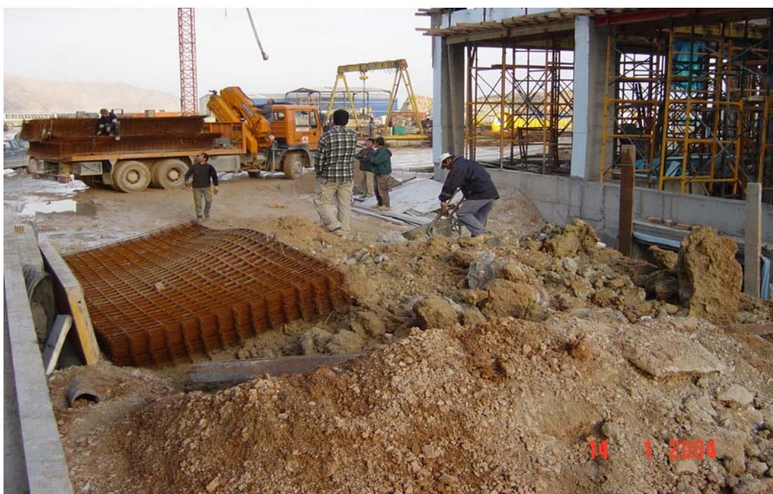
Εικόνα 11 - Υλικό - σωρός που προέκυψε μετά την ανατίναξη
