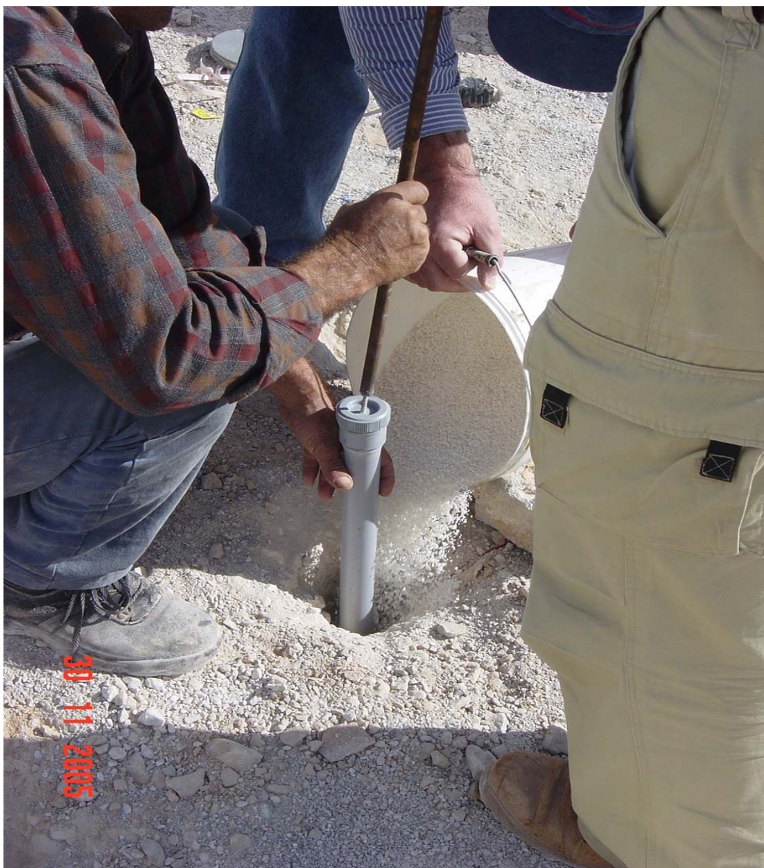
Εικόνα 25 - Κατά την γόμωση. Πλαστικός σωλήνας και ANFO χύδην
