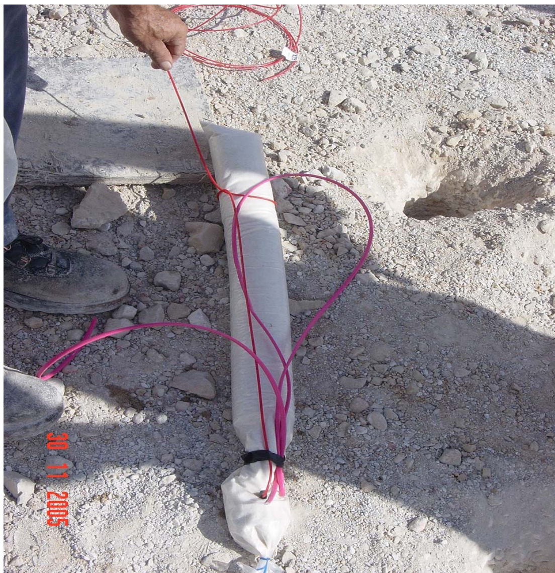
Εικόνα 16 - Φυσίγγιο αμμωνίτη μαζί με ακαριαία θρυαλλίδα
