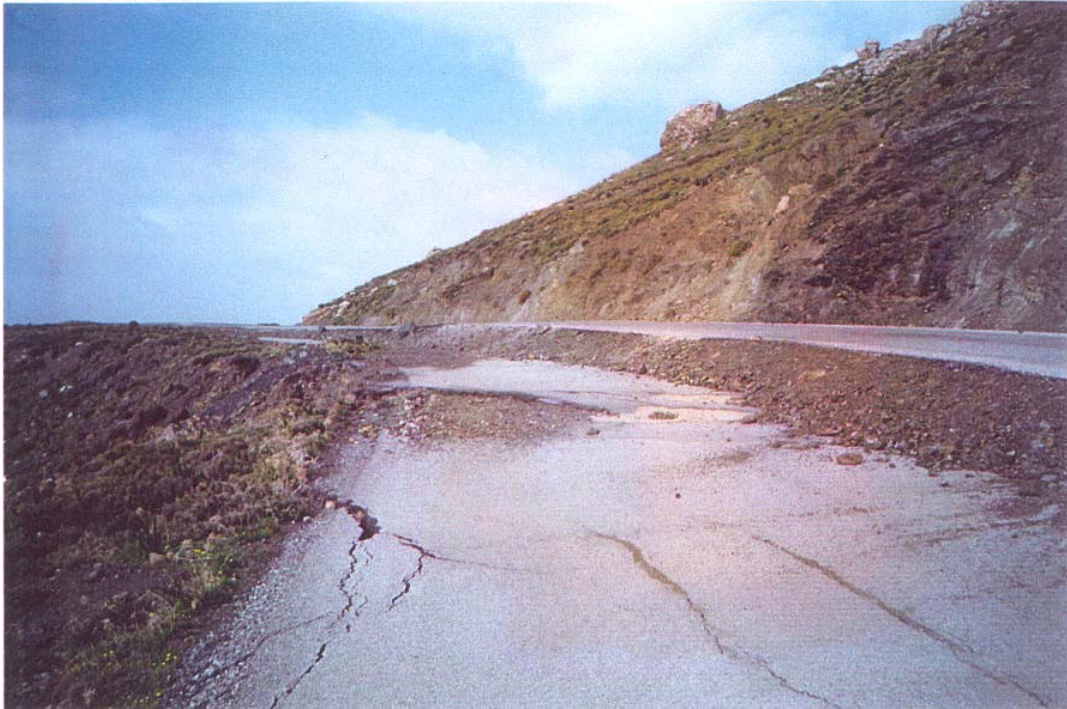
Εικόνα 3.5: Αστοχία στο οδόστρωμα λόγω κατολίσθησης.
