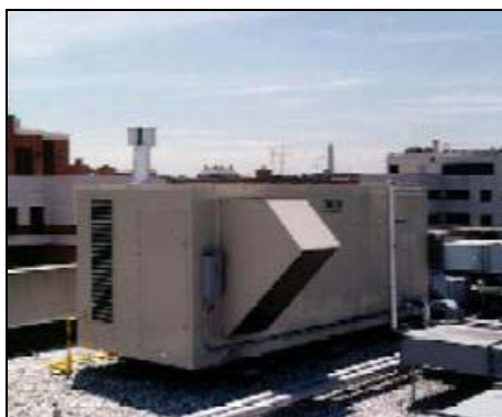
Σχήμα 4.3. Σύστημα ξήρανσης με φυσικό αέριο στην οροφή του ξενοδοχείου Hyatt στην Ουάσιγκτον.
