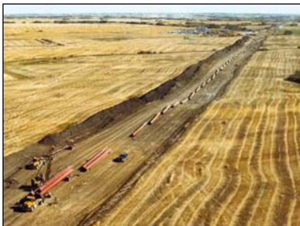
Σχήμα 3.6. Εναπόθεση σωλήνων αγωγού.
