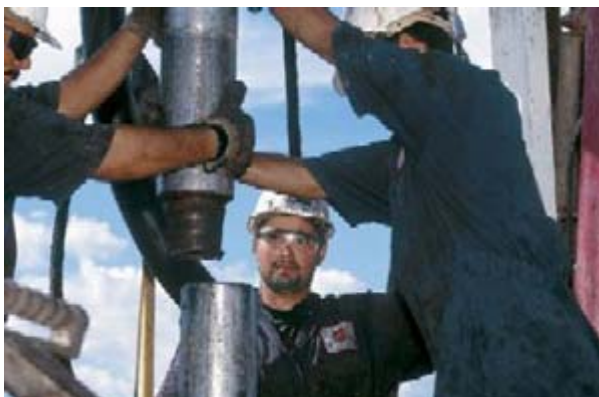
Σχήμα 2.15. Εγκατάσταση επένδυσης φρέατος.
