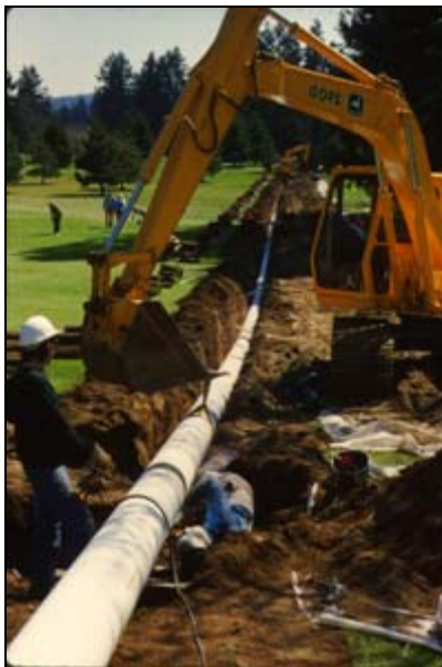
Σχήμα 3.21. Εγκατάσταση μικρής διαμέτρου αγωγών διανομής φυσικού αερίου.
