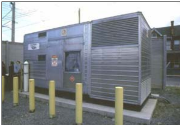
Σχήμα.3.22. Σταθμός συμπίεσης συστήματος διανομής.
