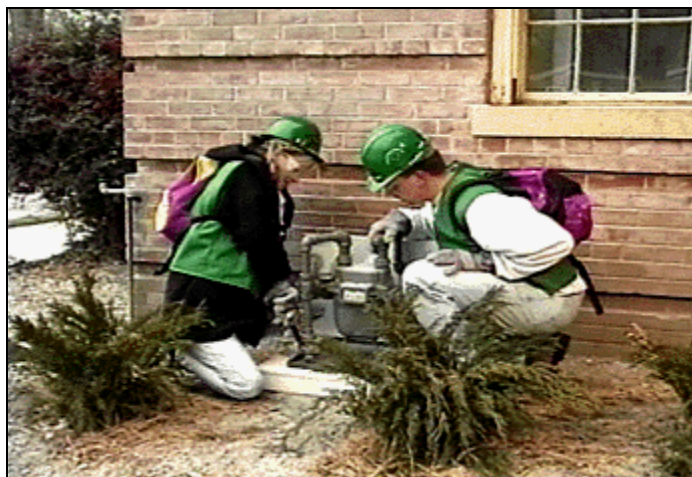
Σχήμα 3.23. Ομάδα άμεσης τεχνικής επέμβασης φυσικού αερίου κατά τον έλεγχο των μετρητών παροχής αερίου.
