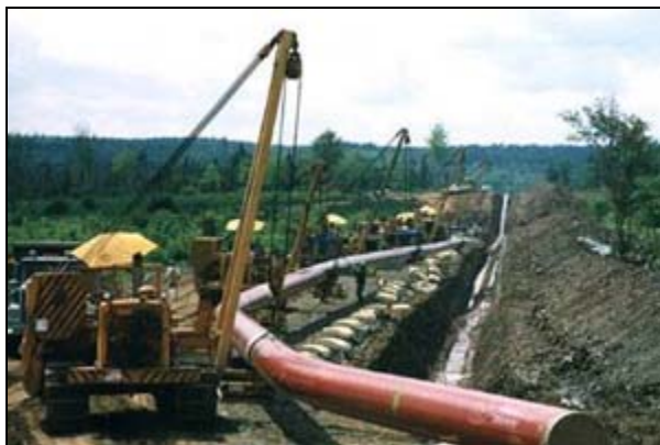
Σχήμα 3.7. Χαμήλωμα της σωλήνωσης.
