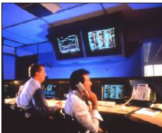
Σχήμα 3.5. Κεντρικός σταθμός ελέγχου αγωγών μεταφοράς φυσικού αερίου.
