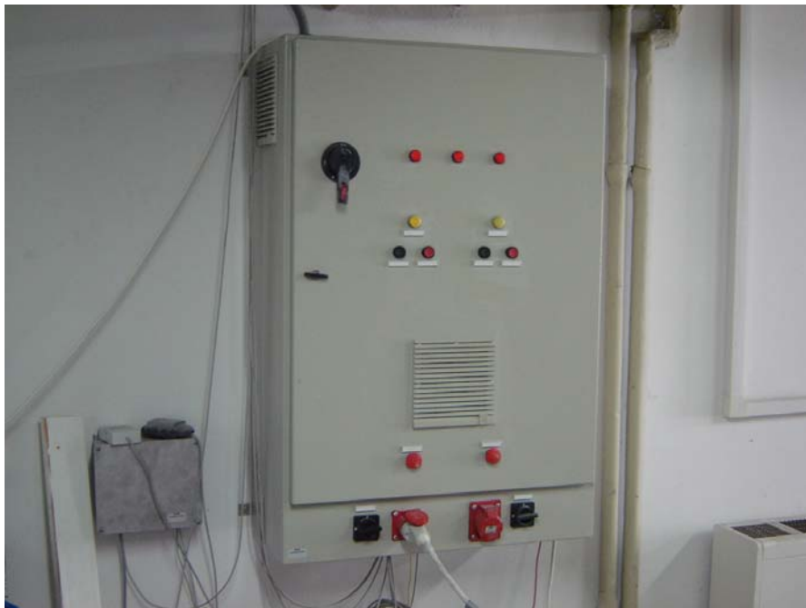
Εικόνα 4-7: Μετατροπέας συχνότητας της LENZE (frequency inverter)
