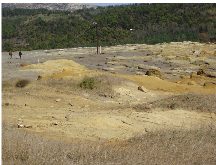
Σχήμα 4.4. Διάβρωση και επιφανειακή οξείδωση αποβλήτων στο φράγμα απόθεσης τελμάτων
