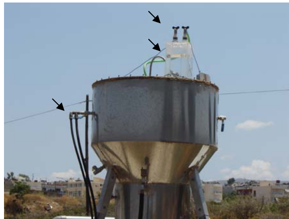
9. Η έξοδος των επεξεργασμένων λυμάτων και του βιοαερίου
