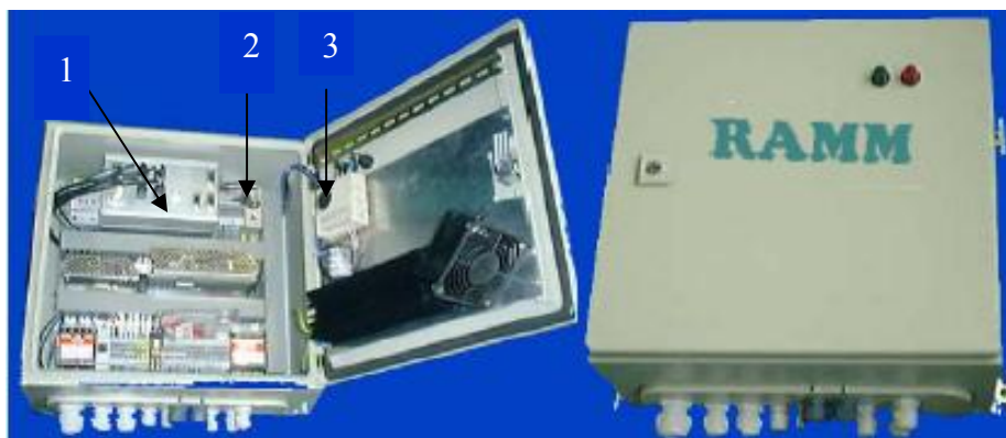
Εικόνα 2.11 : Η μονάδα αξιολόγησης που στην μεταφορική ταινία μαζί με τον αναλυτή όπου :1 η μονάδα τύπου MSC, 2 το κλειδί χειρισμού του κλείστρου ασφαλείας, 3 ο θερμοστάτης, 4 η μονάδα θέρμανσης και 5 οι ασφάλειες προστασίας από υψηλή τάση
