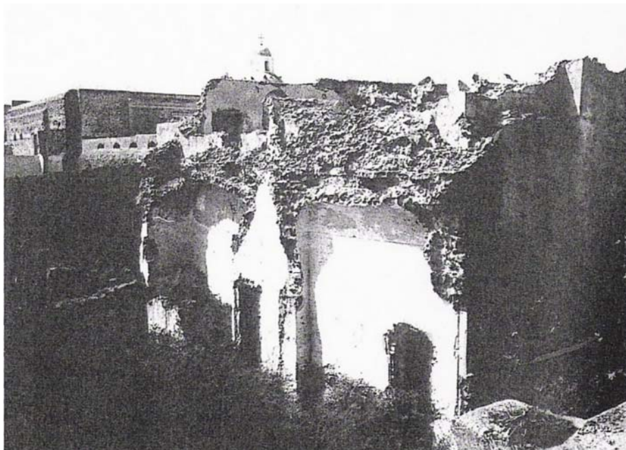
Σχήμα 5.3.2 Καταστροφή σπιτιού στην Θήρα από το σεισμό της 9 ης Ιουλίου 1956.
