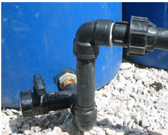
Εικόνα 4.2.2 – Διάταξη εξόδου του επεξεργασμένου λύματος από την πιλοτική μονάδα
