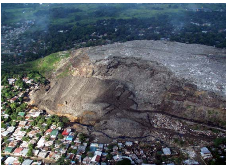
Σχήμα 1.2: Κατολίσθηση πρανού ΧΥΤΑ στις Φιλιππίνες λόγω βροχοπτώσεων
