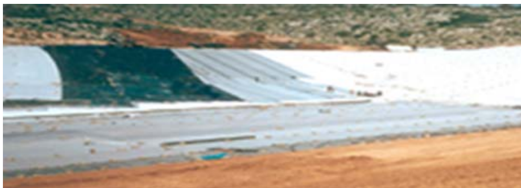
Σχήμα 1.5: Τοποθέτηση αργιλικών υλικών και γεωμεμβρανών
