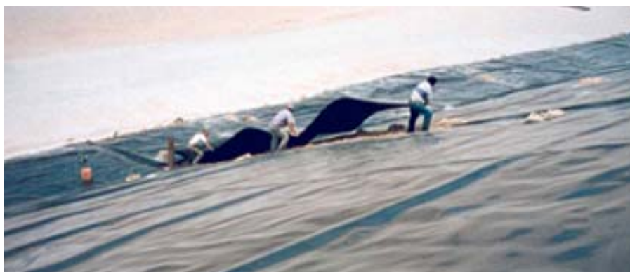
Σχήμα 1.6: Τοποθέτηση γεωμεμβρανών
