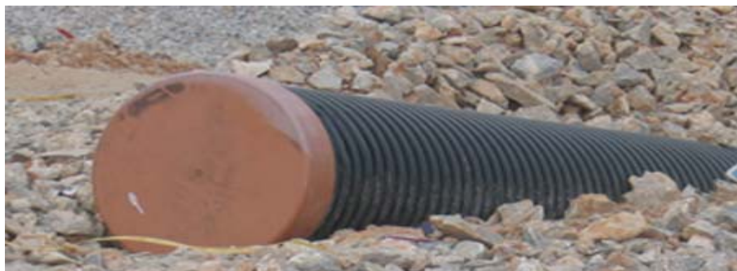
Σχήμα 1.8: Τοποθετημένος αγωγός συλλογής στραγγισμάτων
