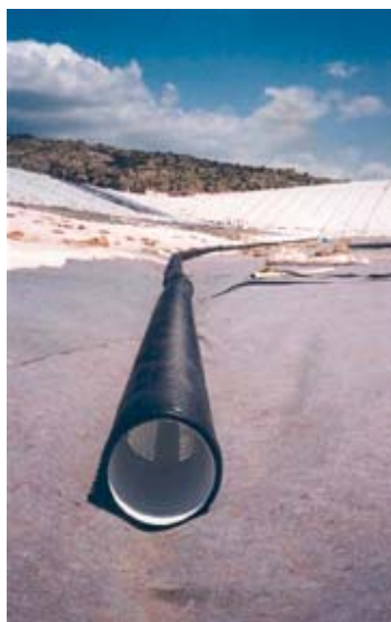
Σχήμα 1.7: Τυπική μορφή αγωγού συλλογής στραγγισμάτων
