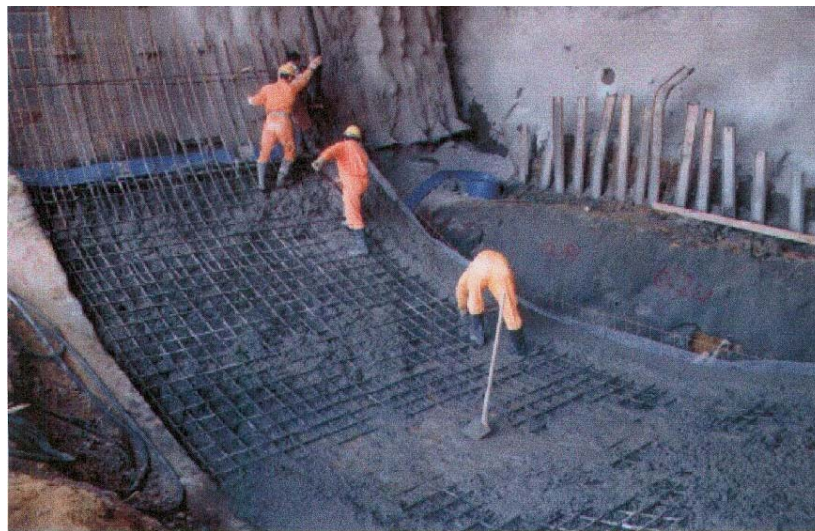
Σχήμα 2.15γ: Σκυροδέτηση του πυθμένα (ΑΕΓΕΚ).
