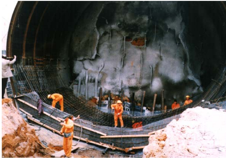
Σχήμα 2.15β: Τοποθέτηση του προκατασκευασμένου κλωβού (ΑΕΓΕΚ).
