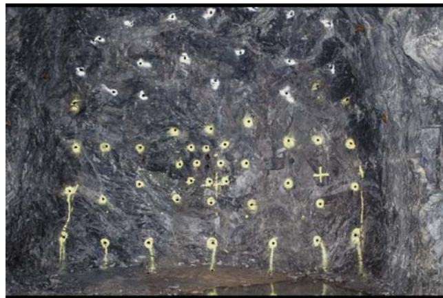
Σχήμα 2.7: Σχεδιασμός ανατίναξης σε μια σήραγγα. Ο διαφορετικός χρωματισμός δηλώνει διαφορετικό χρόνο έκρηξης ( www.atlascopco.com 2004).
