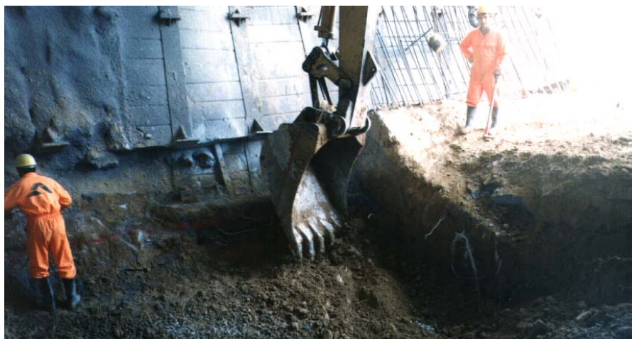
Σχήμα 2.15α: Προετοιμασία δαπέδου για τη τοποθέτηση του ανεστραμμένου θόλου (invert) (Δεδομένα εταιρείας ΑΕΓΕΚ).
