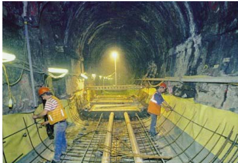
Σχήμα 2.20ε: Ενίσχυση με σκυρόδεμα σε πυθμένα σήραγγας ( www.dr-sauer.com 2004).
