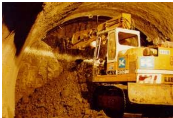
Σχήμα 2.20γ: Εκσκαφή της κορυφής (στέψης) της σήραγγας ( www.dr-sauer.com 2004).
