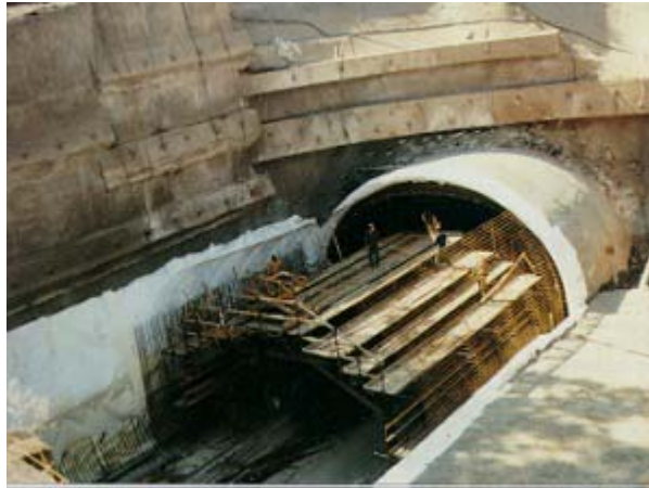
Σχήμα 2.21: Διάνοιξη με Κοπή και Επίχωση ( www.dr-sauer.com 2004).
