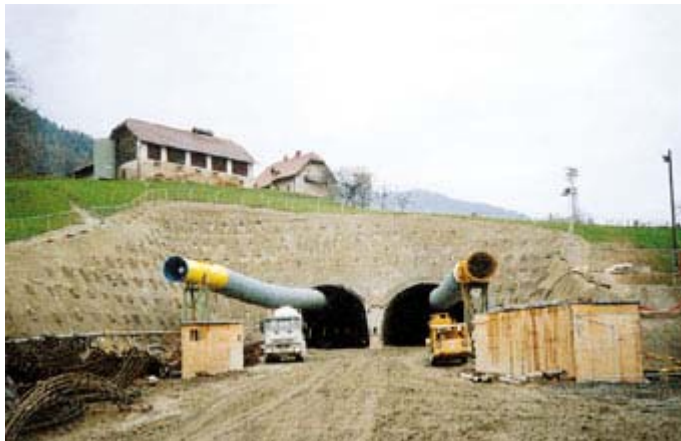
Σχήμα 2.10: Εξαερισμός στη διπλή σπηραγγα Graeber, που συνδέει τη Βιέννη με την Ιταλία ( www.atlascopco.com 2004).
