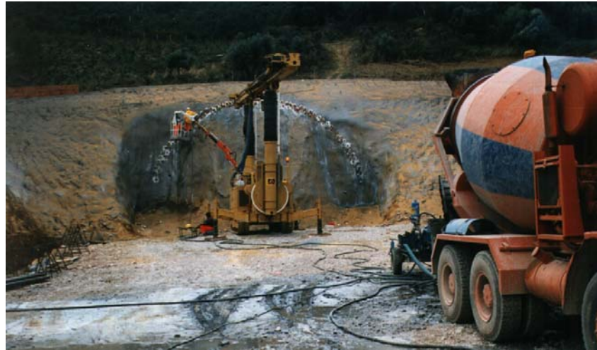
Σχήμα 2.16δ: Ενεμάτωση δοκών προπορείας (ΑΕΓΕΚ).
