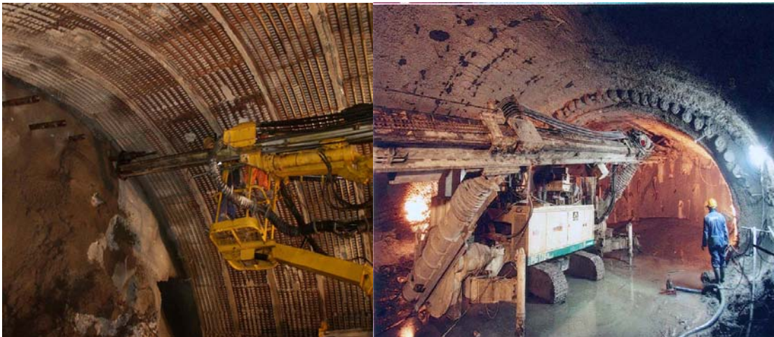
Σχήμα 2.16γ: Δημιουργία οπών και τοποθέτηση δοκών προπορείας με μηχάνημα τύπου Casagrande ( www.dsichile.com 2004).
