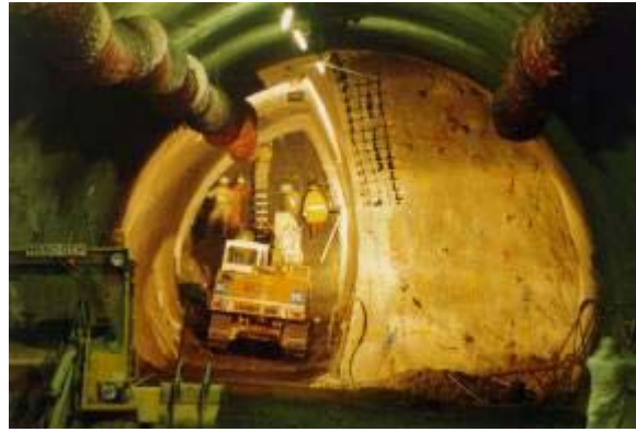
Σχήμα 2.19δ: Εκσκαφή του πρώτου μέρους της διατομής ( www.dr-sauer.com 2004).
