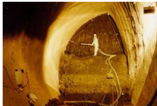
Σχήμα 2.18β: Τοποθέτηση εκτοξευμένου σκυροδέματος ( www.dr-sauer.com , 2004)
