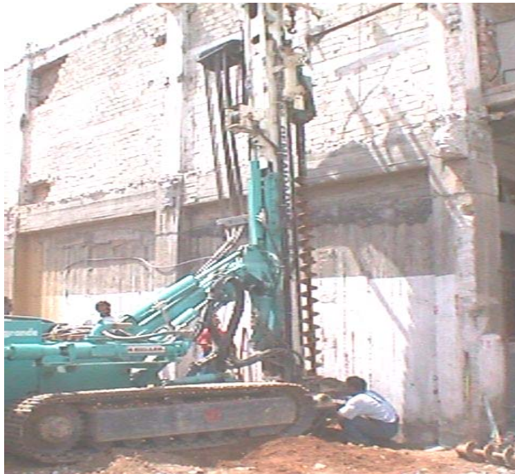
Φωτογραφία 4.5: Εργασίες διάτρησης στη δυτική πλευρά του οικοπέδου.
