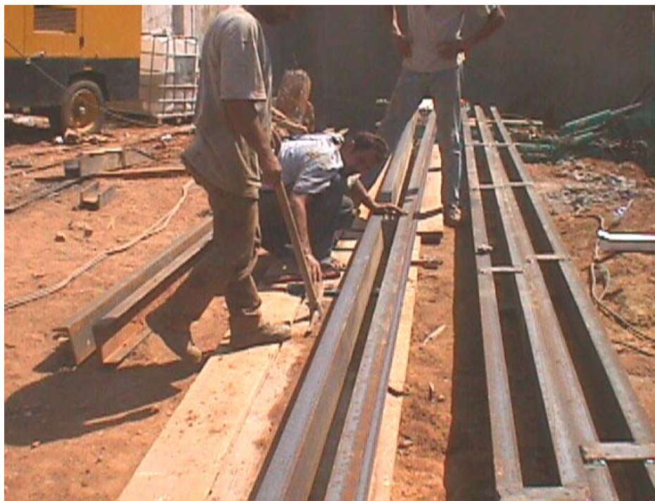
Φωτογραφία 4.21: Κατασκευή σιδηροδοκών.
