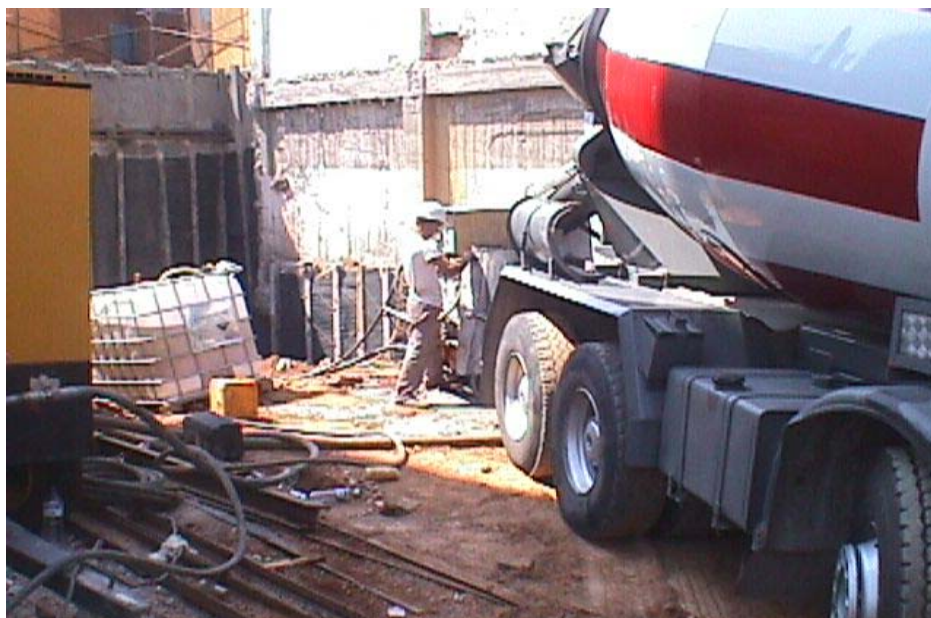
Φωτογραφία 4.18: Παροχή σκυροδέματος στο σύστημα ανάμιξης.
