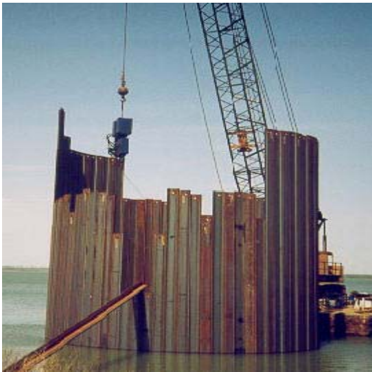
Εικόνα 3.1: Κατασκευή διαφράγματος σε θαλάσσιο περιβάλλον με πασσαλοσανίδες (FAD, 2003)
