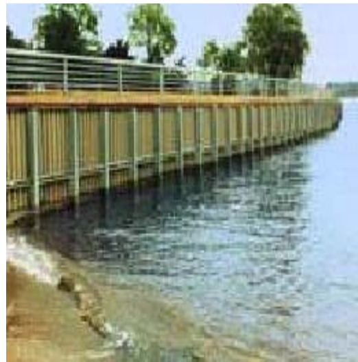
Εικόνα 3.2: Διάφραγμα με πασσαλοσανίδες σε παράκτια περιοχή (FAD, 2003)
