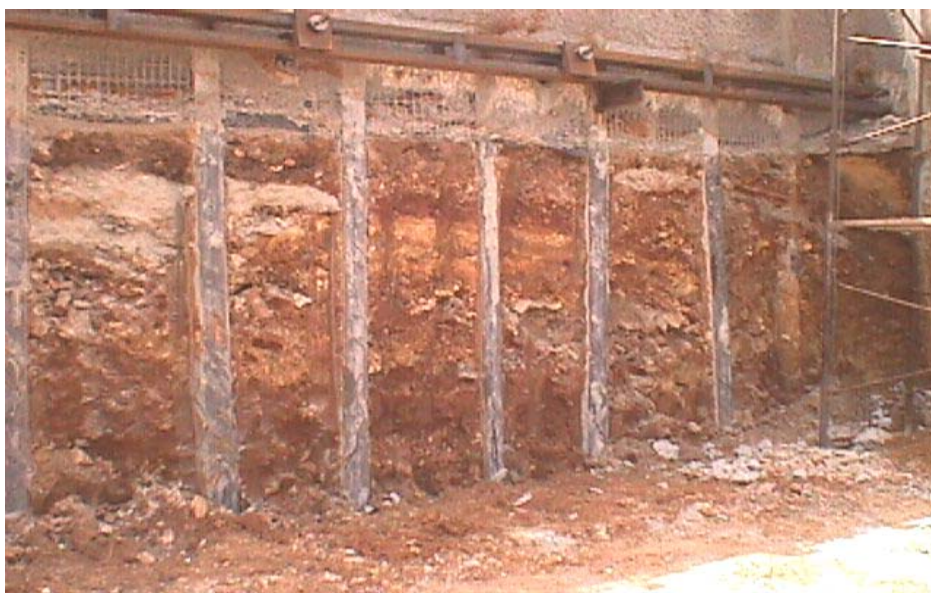
Φωτογραφία 4.2: Εκσκαφή στη στάθμη -5\text{m} , νότια πλευρά τοίχου.
