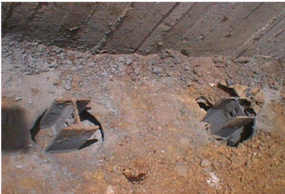
Φωτογραφία 4.8: Σιδηροπάσσαλοι τοποθετημένοι στα διατρήματα.
