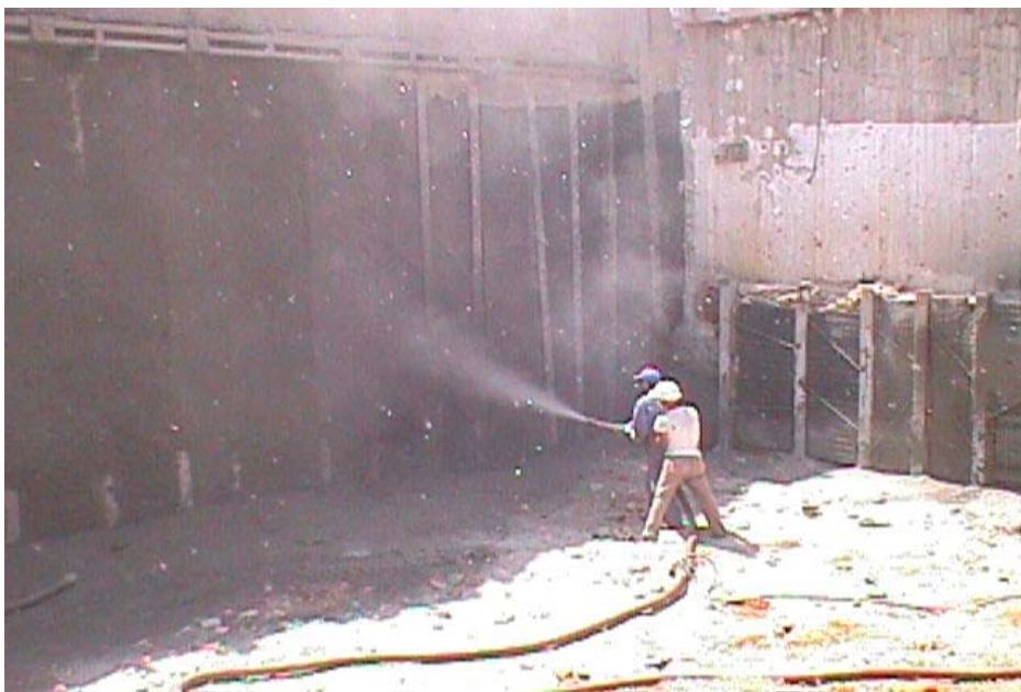
Φωτογραφία 4.14: Εργασίες σκυροδέτησης με εκτοξευδόμενο σκυρόδεμα.
