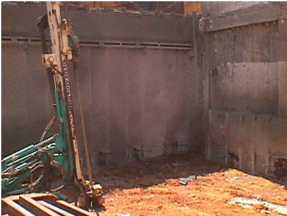
Φωτογραφία 4.19: Άποψη των δύο πλευρών μετά την τοποθέτηση των αγκυρίων.
