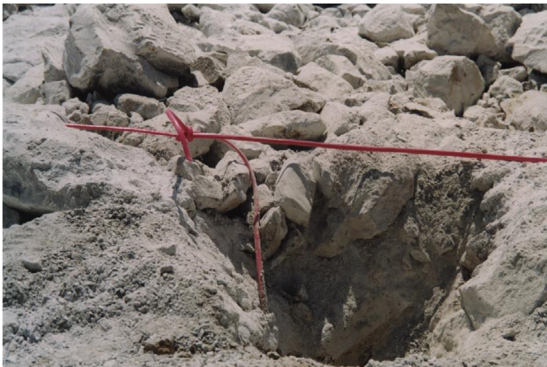
Σχήμα 2.3: Ενδεικτικός τρόπος συνδεσμολογίας ακαριαίας θρυαλλίδας
