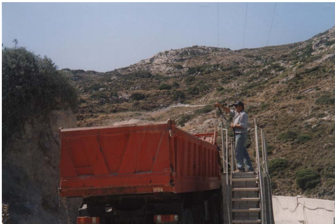
Σχήμα 6.5: Διαβροχή του μεταφερόμενου υλικού για τον περιορισμό της σκόνης.
