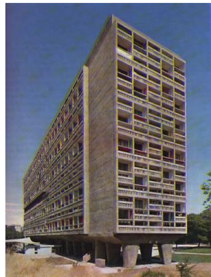
Εικόνα 2.3.30 Unité d’Habitation στη Μασσαλία, Le Corbusier. Ένα παράδειγμα όπου, η μοντέρνα ιδεολογία συνυπάρχει με την κλιματική προσαρμογή, χάρη στις βαθιές εσοχές ηλιοπροστασίας (brise-soleil) και τον διαμπερή σχεδιασμό των διαμερισμάτων
