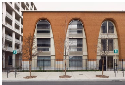
Εικόνα 2.4.10 Το κτίριο “L’Orangerie” στη Λυόν. Ένα σύγχρονο παράδειγμα οικολογικής δόμησης, όπου οι επιβλητικές καμάρες από συμπιεσμένη γη (rammed earth) αναδεικνύουν τις κατασκευαστικές και αισθητικές δυνατότητες των φυσικών υλικών.
