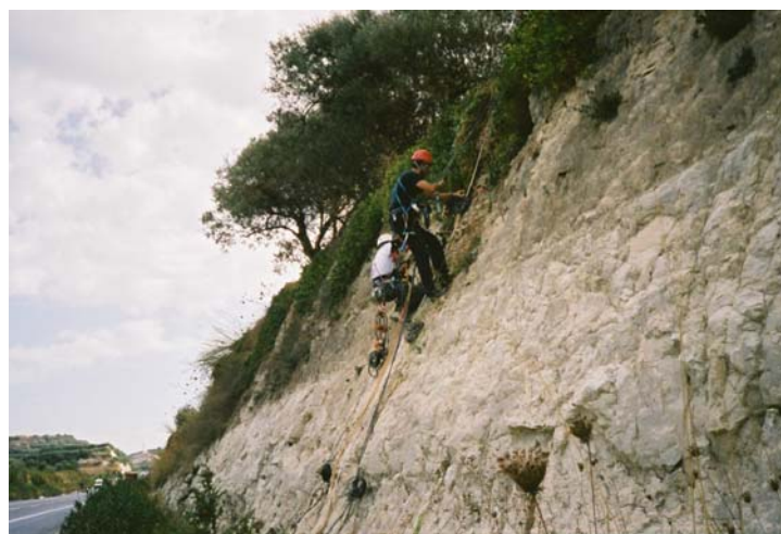
Εικόνα 6.18. Εργασίες για την τοποθέτηση των γεωφώνων στην παρειά του πρανούς.
