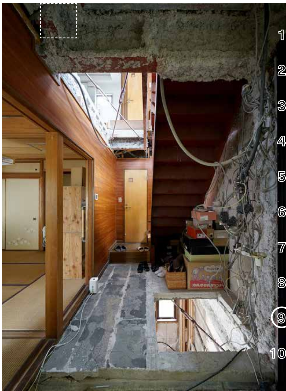
▲ΕΙΚΟΝΑ 163-164: ↓ Δημιουργία κατακόρυφων ανοιγμάτων, που συνδέουν όλα τα επίπεδα του κτιρίου.
