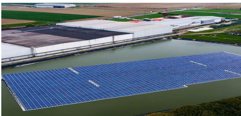
ο) Εικόνα 2.2.9 Water Storage FPV in Belgium Hydrelia® Classic by Ciel & Terre
