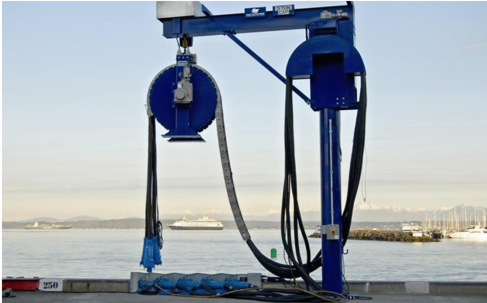
Εικόνα 4.7: Γερανός μεταφοράς καλωδίων [69].
