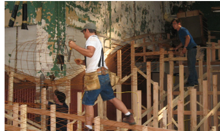
3.24 Η τοποθέτηση του μεταλλικού πλέγματος
