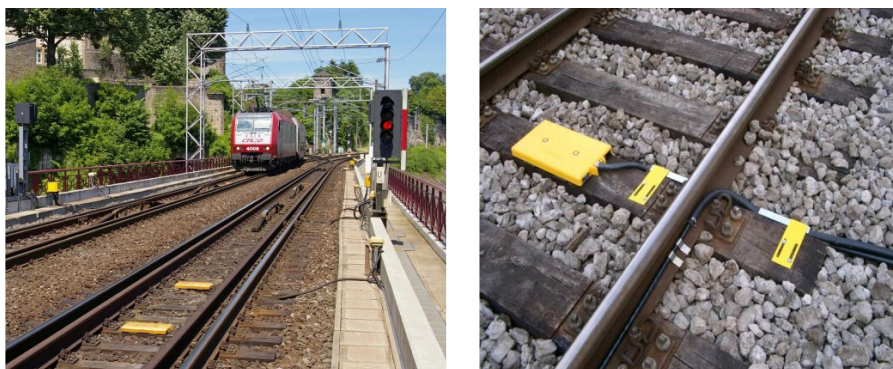
Εικόνα 2.1: Παρατρόχιος εξοπλισμός ECTS (Πηγή : Ευρωπαϊκό Ελεγκτικό Συνέδριο 2017)
