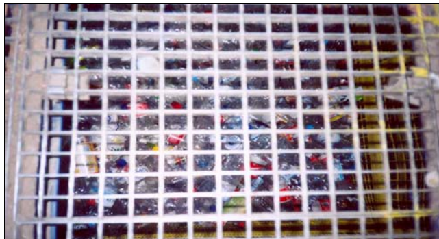
Εικόνα 5.2. Μεταλλική διάτρητη σχάρα του δαπέδου των εξέδρων διαλογής
