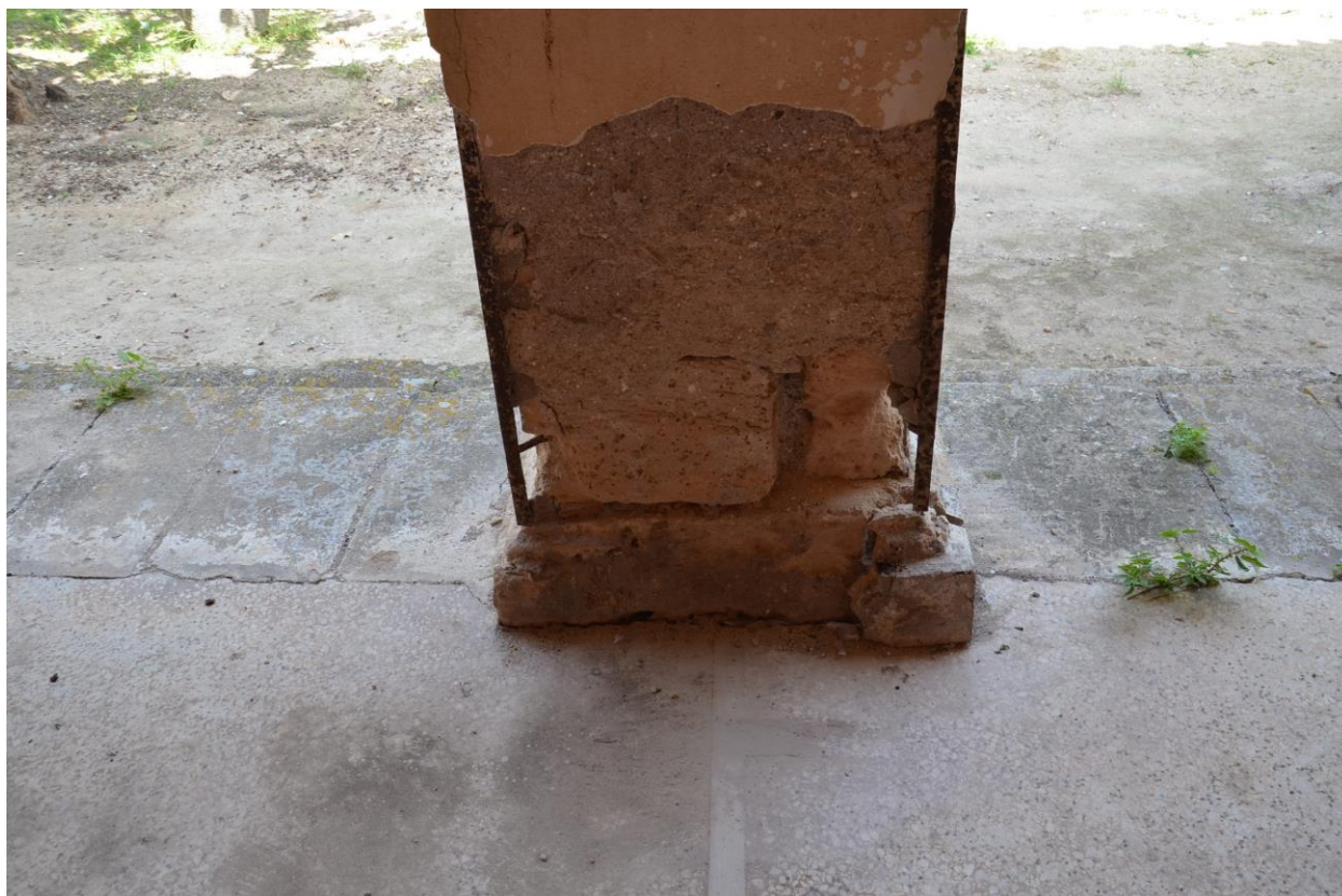
Εικ. 30_Εκτεταμένη φθορά της βάσης του πεσσού.
