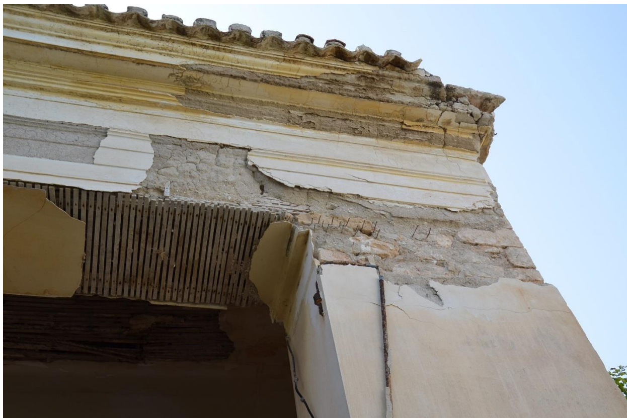
Εικ. 30_Αλλοίωση τραβηχτών της όψης.
