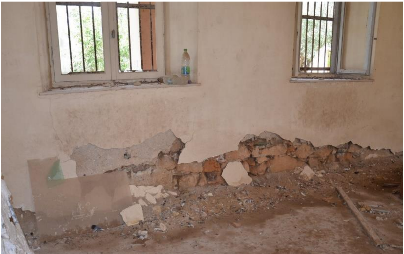
Εικ. 15_Τρόπος δόμησης φέρουσας τοιχοποιίας.
