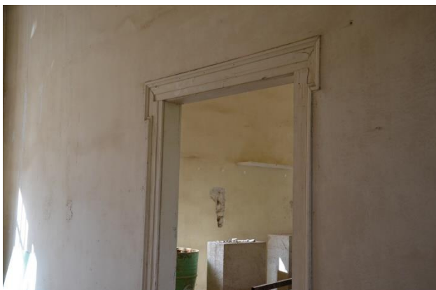
Εικ. 21_Άποψη κασώματος πλίνθινης τοιχοποιίας
