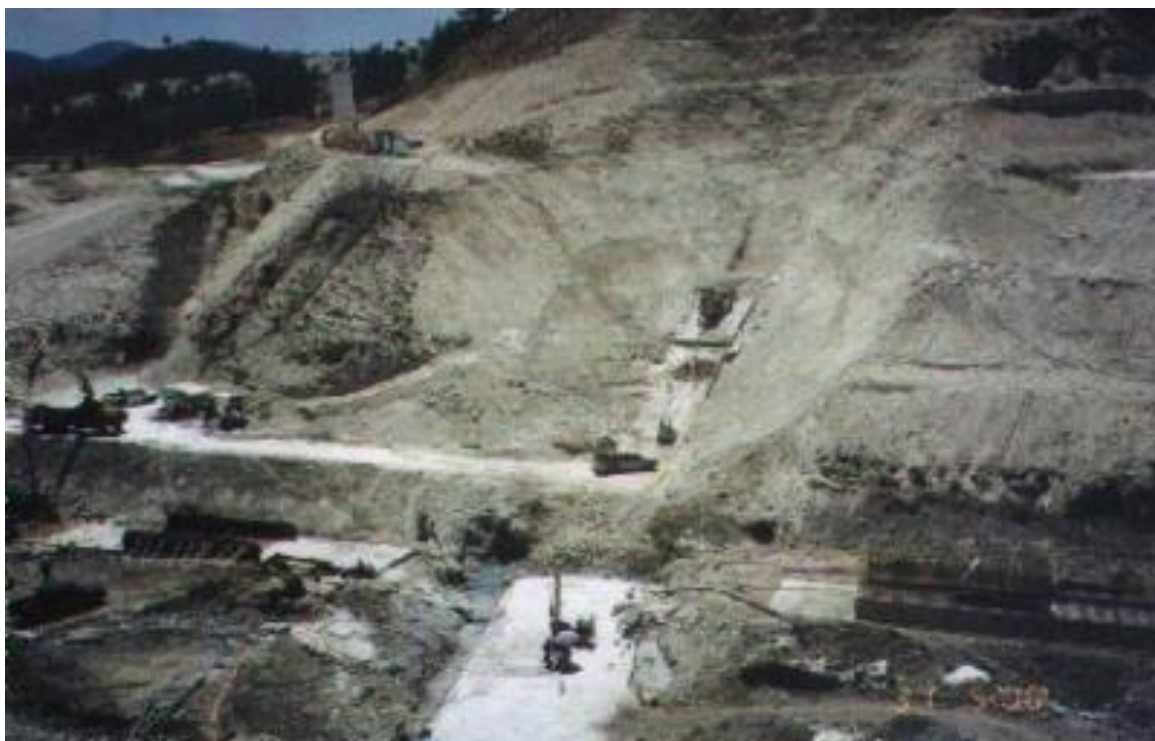
Εικόνα 6-3: Εκσκαφή αριστερού αντερείσματος (Πηγή: Τμήμα Αναπτύξεως Υδάτων Κύπρου ).
