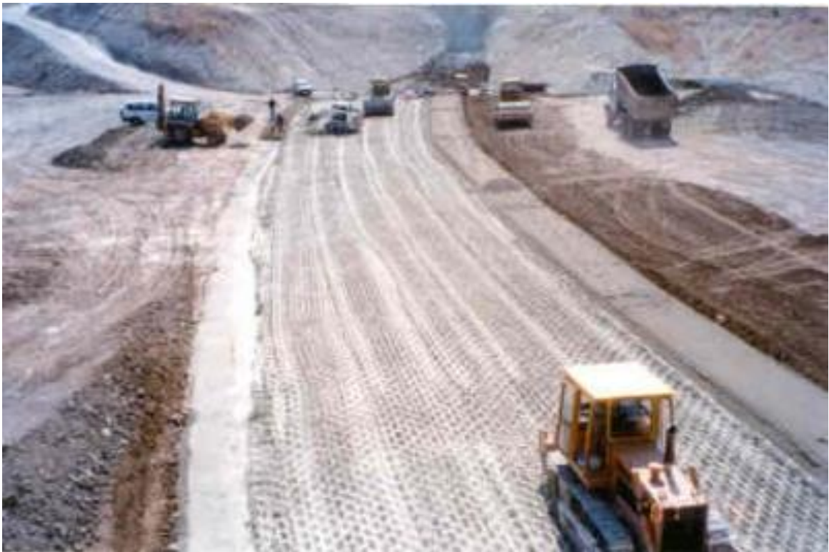
Εικόνα 6-7: Κατασκευή κυρίως αναχώματος (Πηγή: Τμήμα Αναπτύξεως Υδάτων Κύπρου ).
