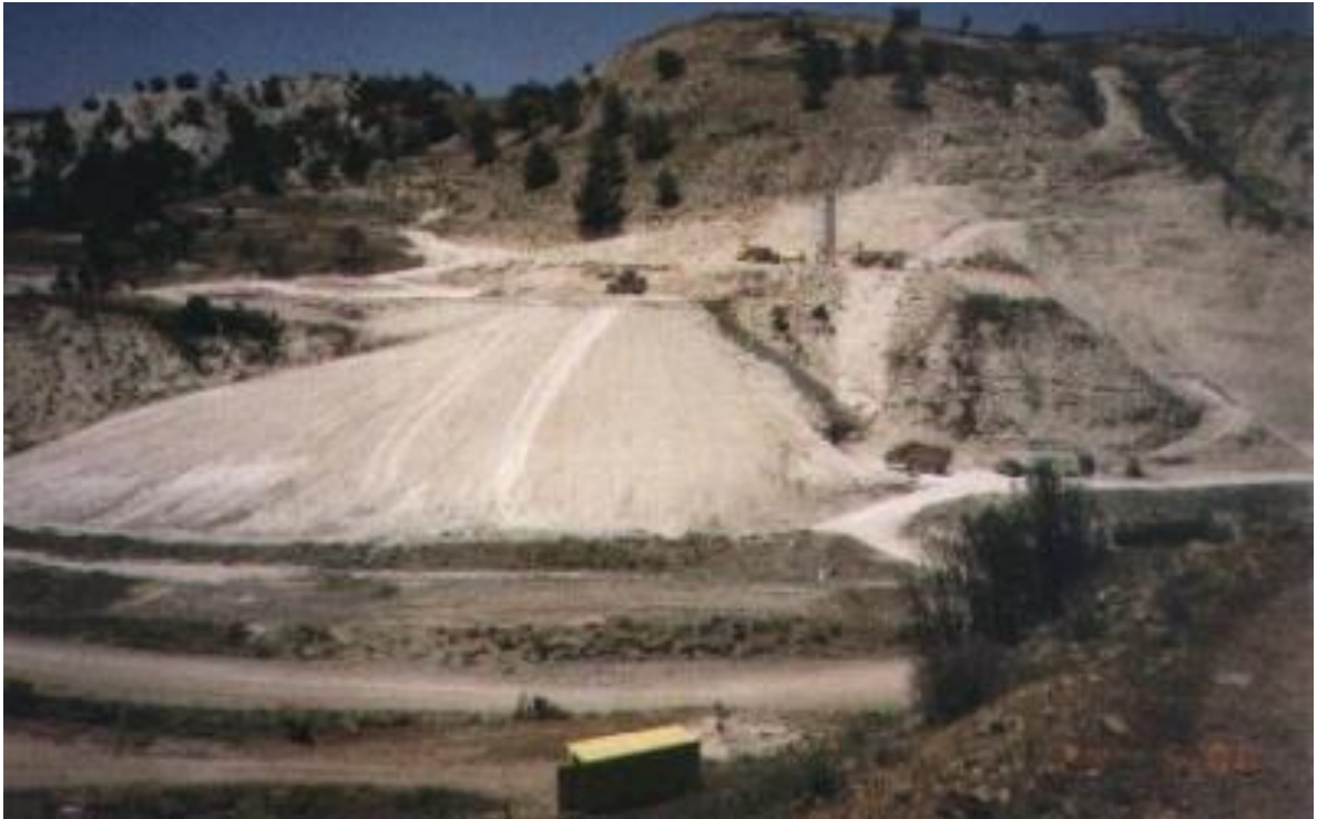
Εικόνα 6-4: Ανάντι αντίποδας υπό κατασκευή (Πηγή: Τμήμα Αναπτύξεως Υδάτων Κύπρου ).
