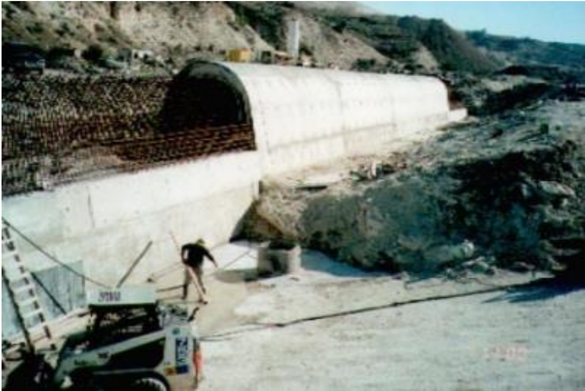
Εικόνα 6-13: Κατασκευή των έργων υδροληψίας στη κοίτη του ποταμού (Πηγή: Τμήμα Αναπτύξεως Υδάτων Κύπρου ).
