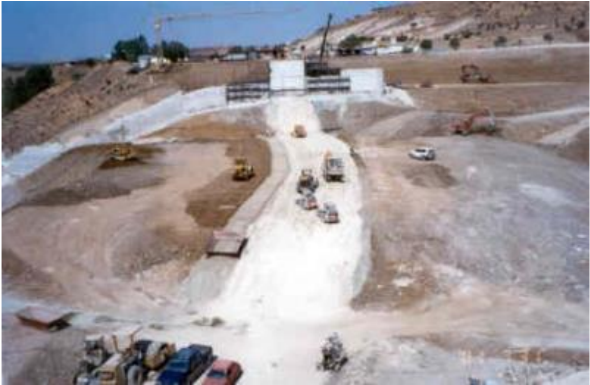
Εικόνα 6-6: Κυρίως ανάχωμα και υπερχειλιστής (Πηγή: Τμήμα Αναπτύξεως Υδάτων Κύπρου ).
