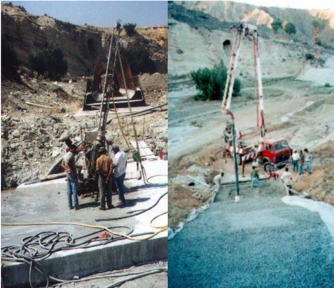
Εικόνα 6-11: Εργασίες τσιμεντενέσεων στην κοίτη του ποταμού Πεδιαίου (Πηγή: Τμήμα Αναπτύξεως Υδάτων Κύπρου ).
