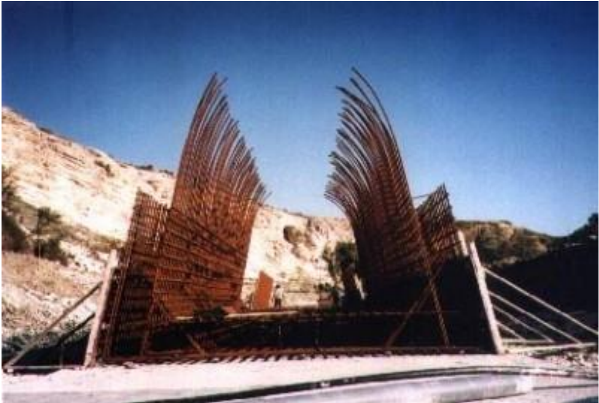
Εικόνα 6-1: Κατασκευή οχετού υδροληψίας στο φράγμα Ταμασσού (Πηγή: Τμήμα Αναπτύξεως Υδάτων Κύπρου ).
