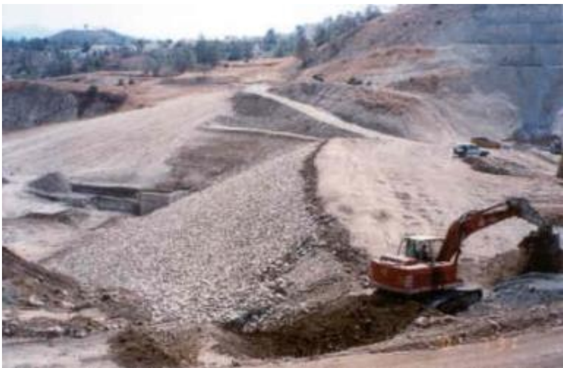
Εικόνα 6-5: Ανάντι πλευρά του κυρίως αναχώματος και ανάντι αντίποδας (Πηγή: Τμήμα Αναπτύξεως Υδάτων Κύπρου ).
