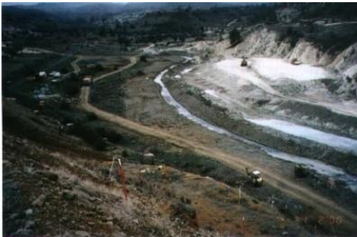
Εικόνα 6-2: Κατασκευή αντίποδα ανάντι του φράγματος Ταμασσού (Πηγή: Τμήμα Αναπτύξεως Υδάτων Κύπρου ).
