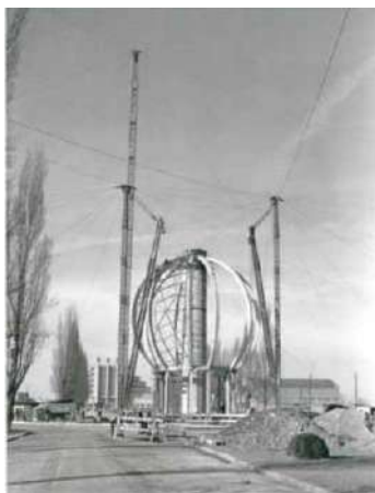
16.5 Φωτογραφία από την κατασκευή, Atomium Pavillon Expo 1958
