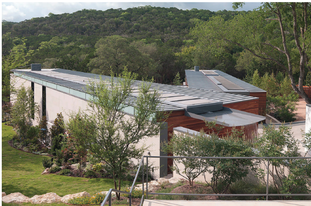
Εικόνα 46. Cascading Creek House | Bercy Chen Studio | 2012. Texas. Διαμόρφωση δώματος για τη δημιουργία μιας φυσικής λεκάνης για τη συλλογή του βρόχινου νερού.
