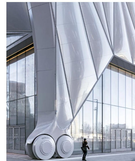
(εικόνα 53) Ο μηχανισμός μετακίνησης του κελύφους
